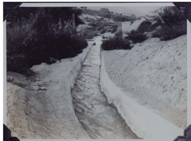
CANAL CAPLINA REVESTIDO DESDE CALIENTES
