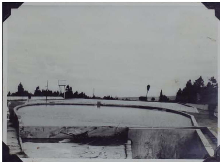
TANQUE OVOIDE Y TANQUE DE ALMACENAMIENTO DE AGUA CRUDA
