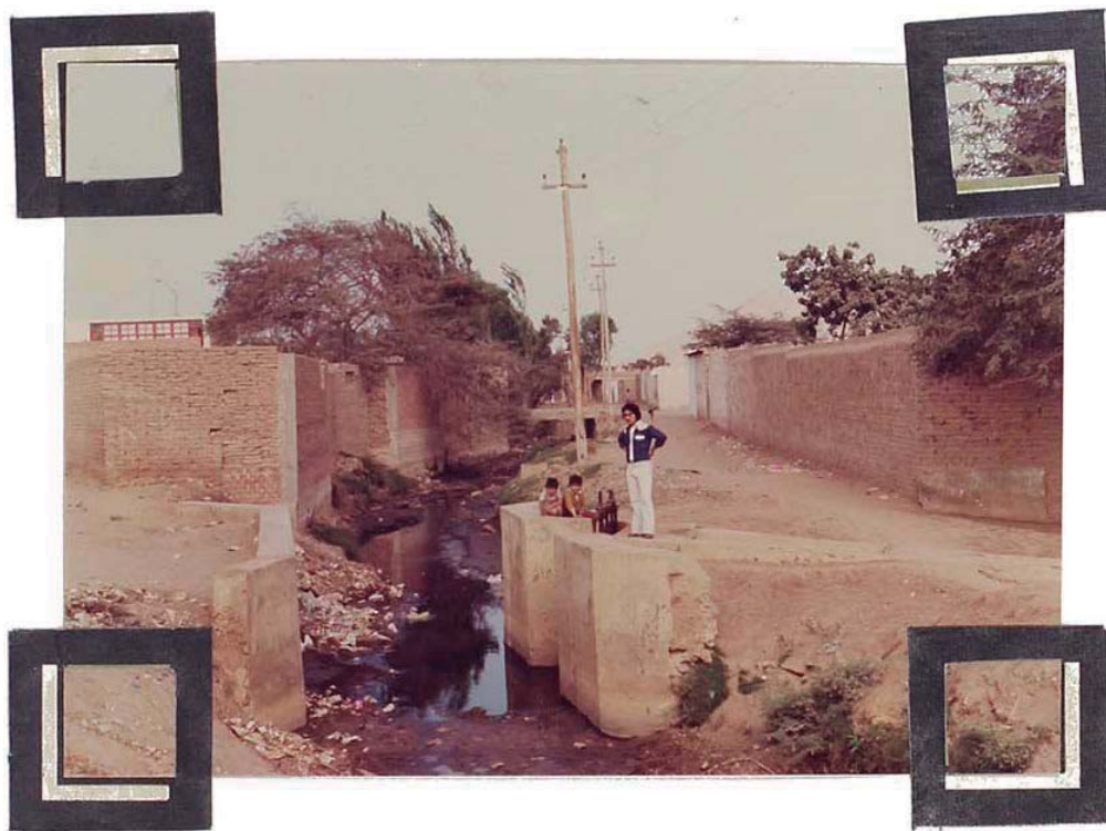
El suscrito, inspeccionando el canal mas importante del valle : " LA MOCHICA "
