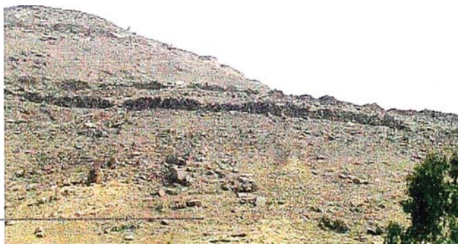
Vista de las murallas de la Fortaleza de Collique (Foto: INC, 2002)
