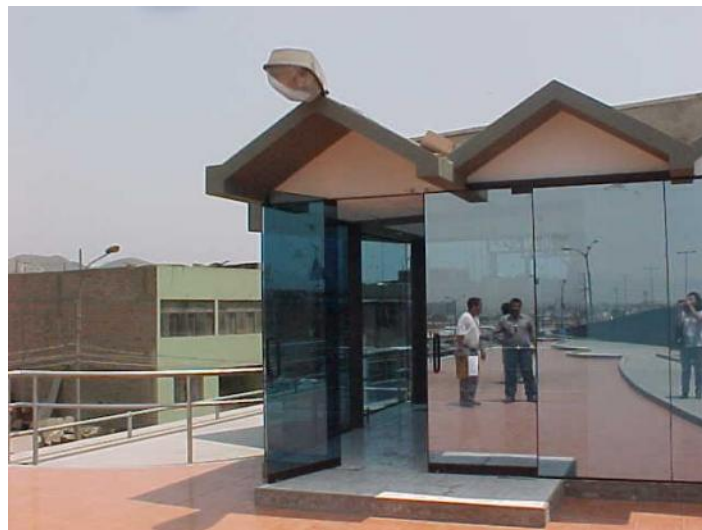
Sus muros, son de dry wall y de mamparas de vidrio templado
