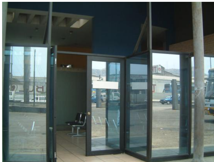
Vistas de las puertas de salida hacia el patio de maniobras desde la sala de espera.
