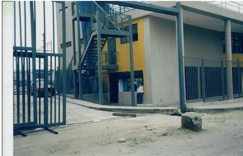
Estructuras Metálicas, escalera y puerta de entrada por Av. Alfredo Mendiola
