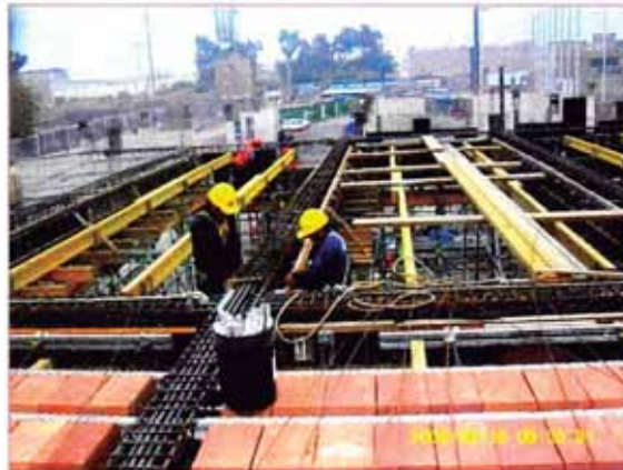
ENCOFRADO LOSA ALIGERADA
