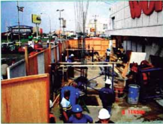
CONSTRUCCION DE ZAPATAS
