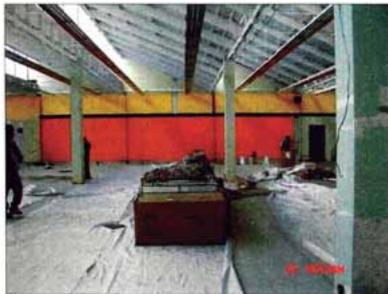
INSTALACION DE LUMINARIAS
