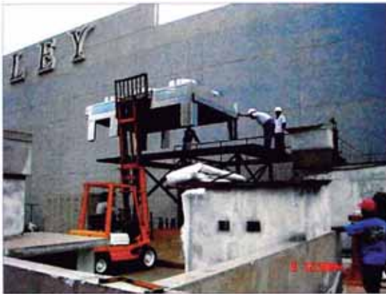
MONTAJE DE CONDENSADOR
