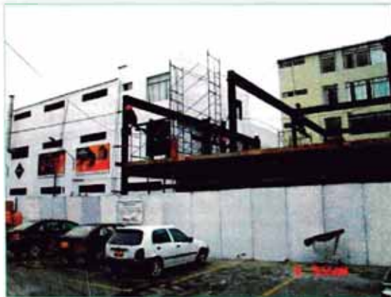
MONTAJE DE ESTRUCTURA METALICA
