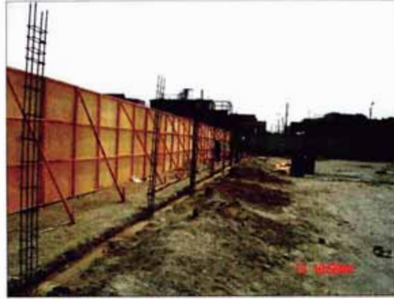
CONSTRUCCION MURO PERIMETRICO
