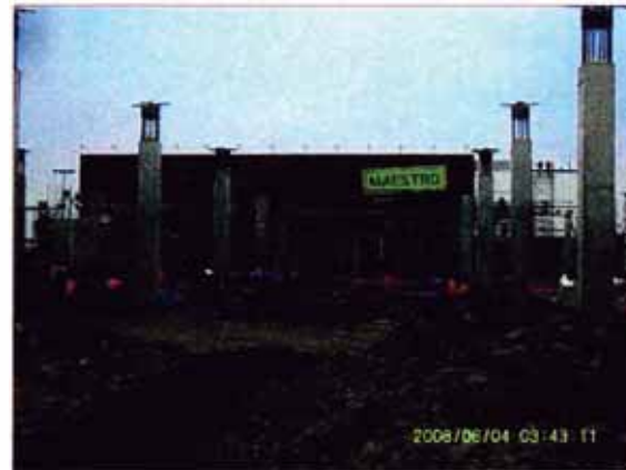
COLUMNAS DE CONCRETO
