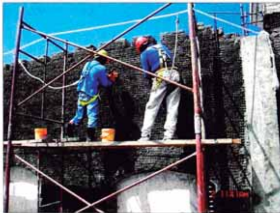
REFUERZO DE FACHADA CON MALLA
