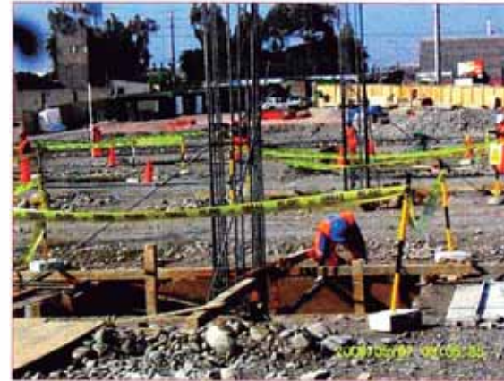
CONSTRUCCION DE ZAPATAS
