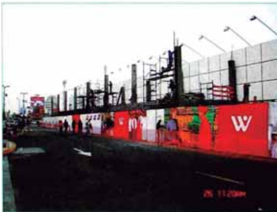
CONSTRUCCION DE COLUMNAS
