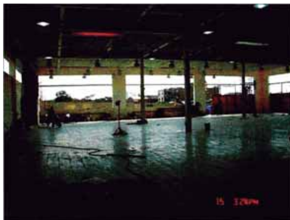
INSTALACION PISO CERAMICO
