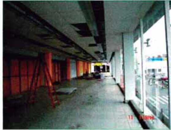
INSTALACION DE LUMINARIAS
