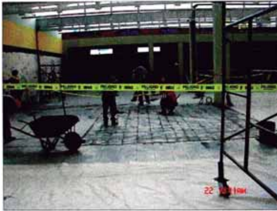
INSTALACION PISO - CERAMICO
