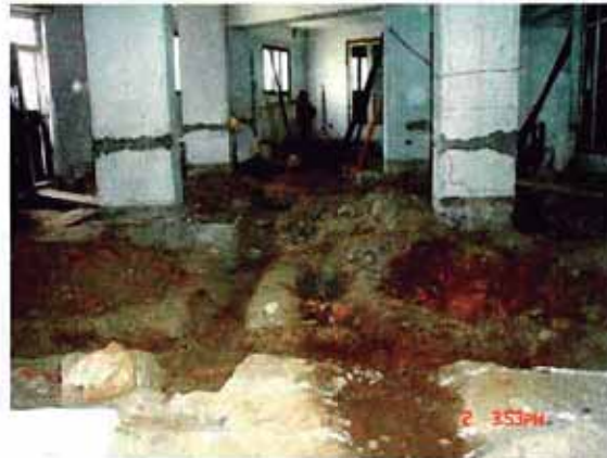
TRABAJOS DE CIMENTACION
