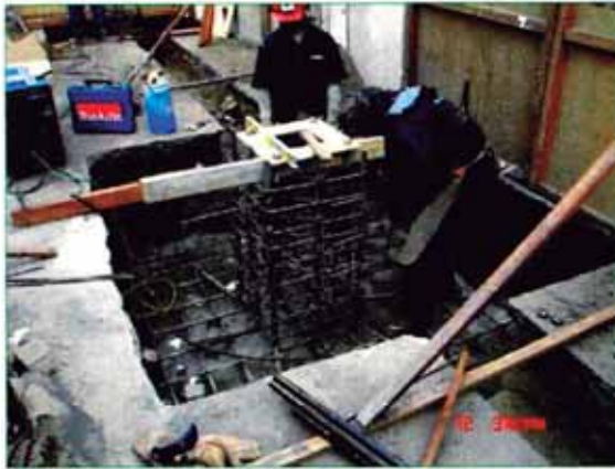
CONSTRUCCION DE ZAPATA
