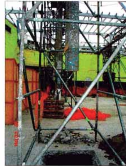
REPARACION DE COLUMNA
