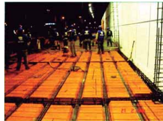
VACEADO LOSA ALIGERADA
