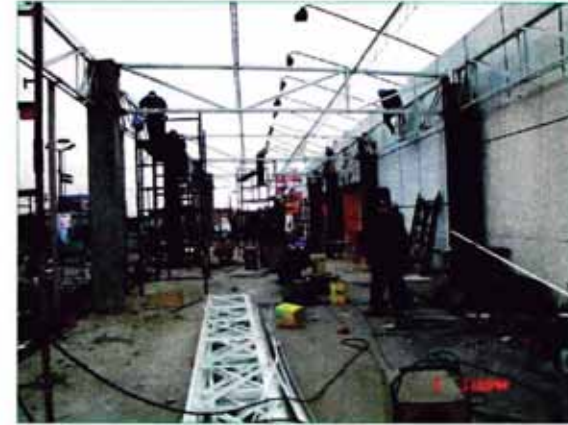
CONSTRUCCION TECHO METALICO
