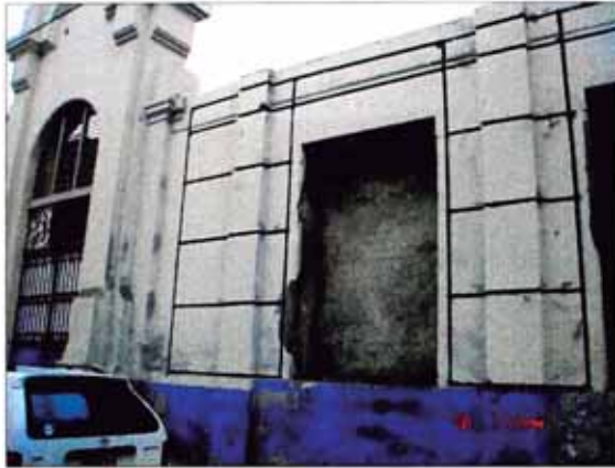
REFUERZO DE FACHADA CON ZUNCHOS
