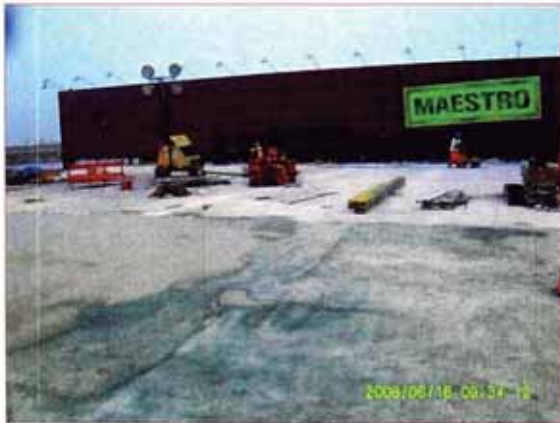
LOSA PLAYA DE ESTACIONAMIENTO
