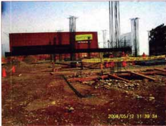
CONSTRUCCION DE COLUMNAS
