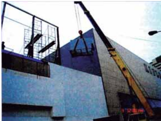
MONTAJE DE EQUIPO DE FRIO
