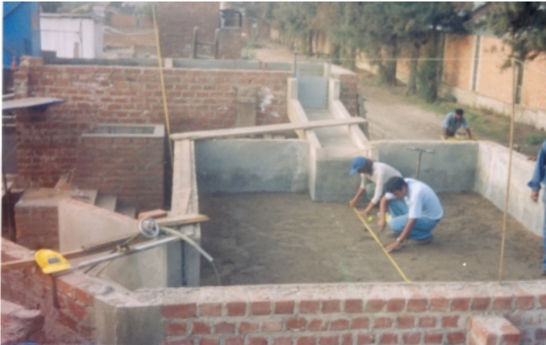
Foto N° 09: Fase I - Se observa la colocación de las bolas de color en tres ejes paralelos a la rápida. De modo preliminar estas bolas nos indicarán la profundidad de erosión
