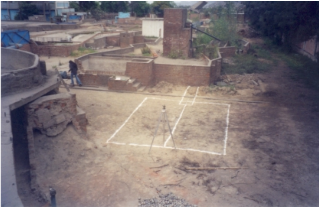
Foto 4.1: Proceso constructivo: Vista del replanteo del área del vertedero (rápida) y cuenco.
