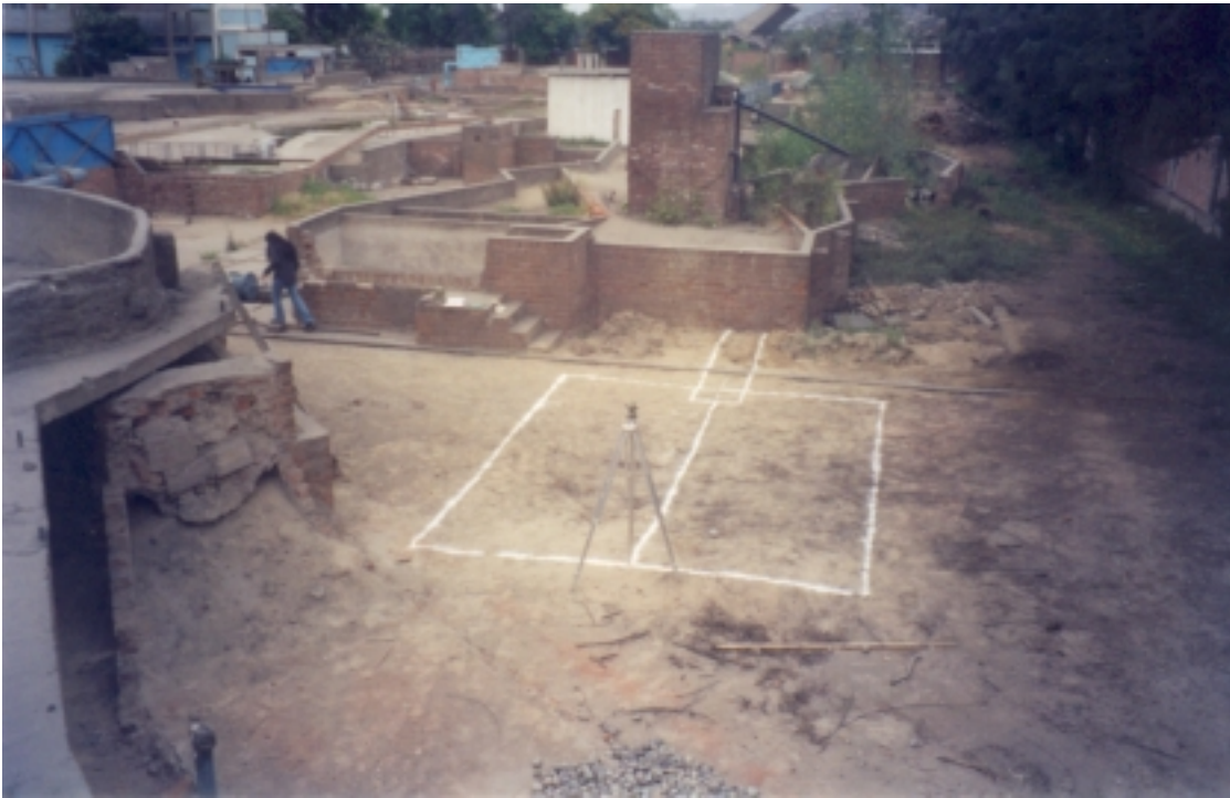
Foto N° 01: Proceso constructivo - Vista del replanteo del área del vertedero (rápida) y cuenco.
