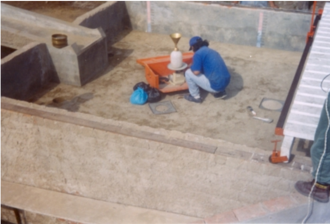
Foto N° 10: Fase I – Ejecución de la prueba del cono de arena para determinar la densidad seca del material.
