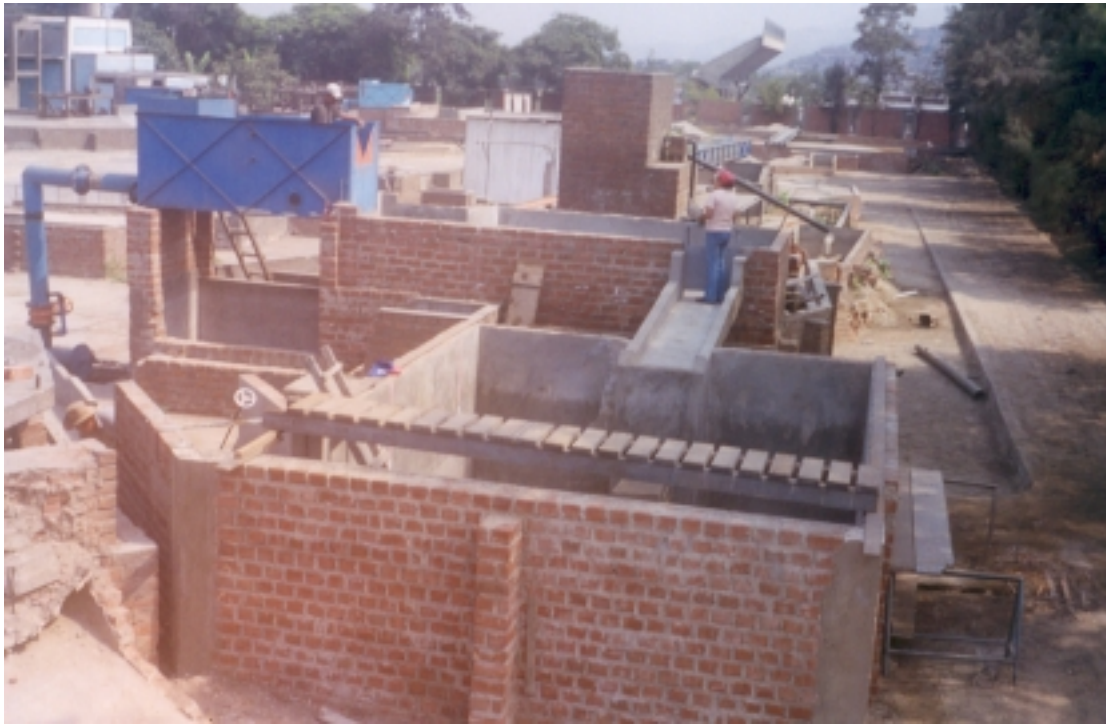
Foto N° 05: Vista panorámica del modelo. Se puede observar el tanque del vertedero, poza de ingreso, la rápida con el ski, el cuenco y el canal de retorno.
