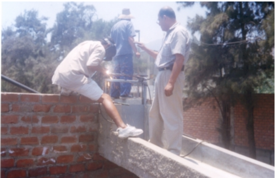
Foto N° 04: Vista de la rápida y salto de ski terminada. Así también la colocación de la compuerta metálica, plana.
