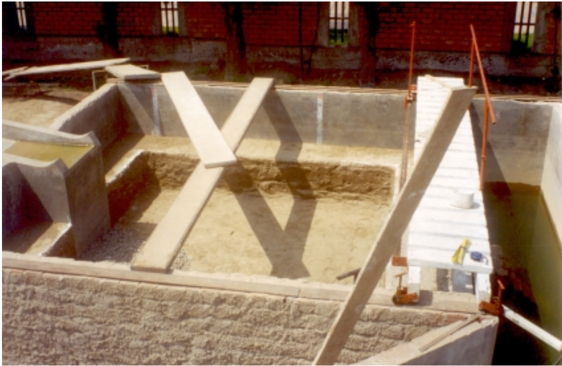
Foto N° 29: Vista del proceso de llenado del cuenco con el material (grava media – d_{50} = 17.88 mm) para iniciar la Fase II.
