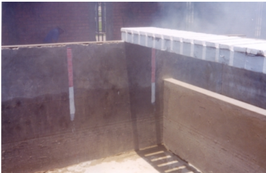
Foto N° 06: Vista de las reglas limnimétricas pintadas en la pared del cuenco para medir los niveles en el cuenco.
