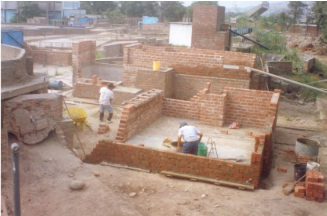
Foto N° 02: Proceso constructivo - Vista panorámica del proceso constructivo del modelo físico.
