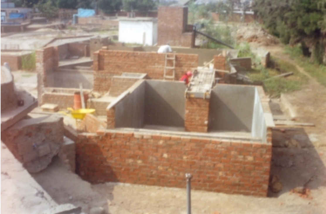
Foto N° 03: Proceso constructivo - Vista del encofrado de la rápida y colocación de los tubos en el eje, esto nos permitirá medir presiones a través del uso de los translucer.
