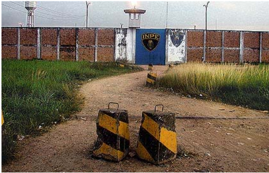
Establecimiento Penitenciario de Pucallpa - construido sin normas técnicas para rehabilitar al interno
