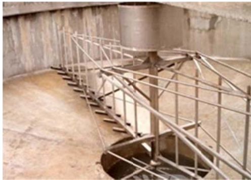
Figura 3. 30: Arreglo típico de brazos y rastras en un espesador. Tomado de Estruagua (2010)
