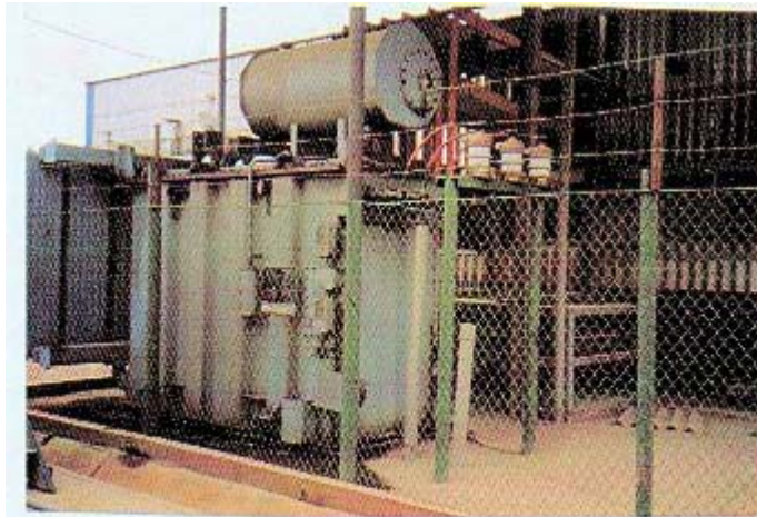
Foto NO.30 Rectificadores instalados al exterior de la Planta de Electrodeposición.
