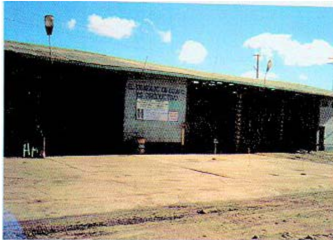
Foto NO.43 Area separada para el almacenamiento de llantas y accesorios de jebe. Apréciase el orden y el aviso de seguridad.
