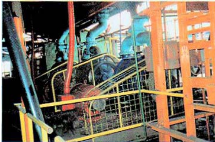
Foto NO.65 Guardas de protección en las zonas móviles de las maquinarias y equipos.
