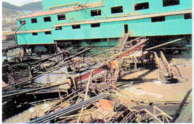
Foto NO.23 Tanques espesadores instalados al exterior del área de flotación.
