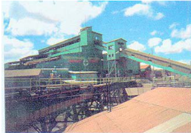
Foto NO.17 Vista panorámica de la Planta Concentradora.
