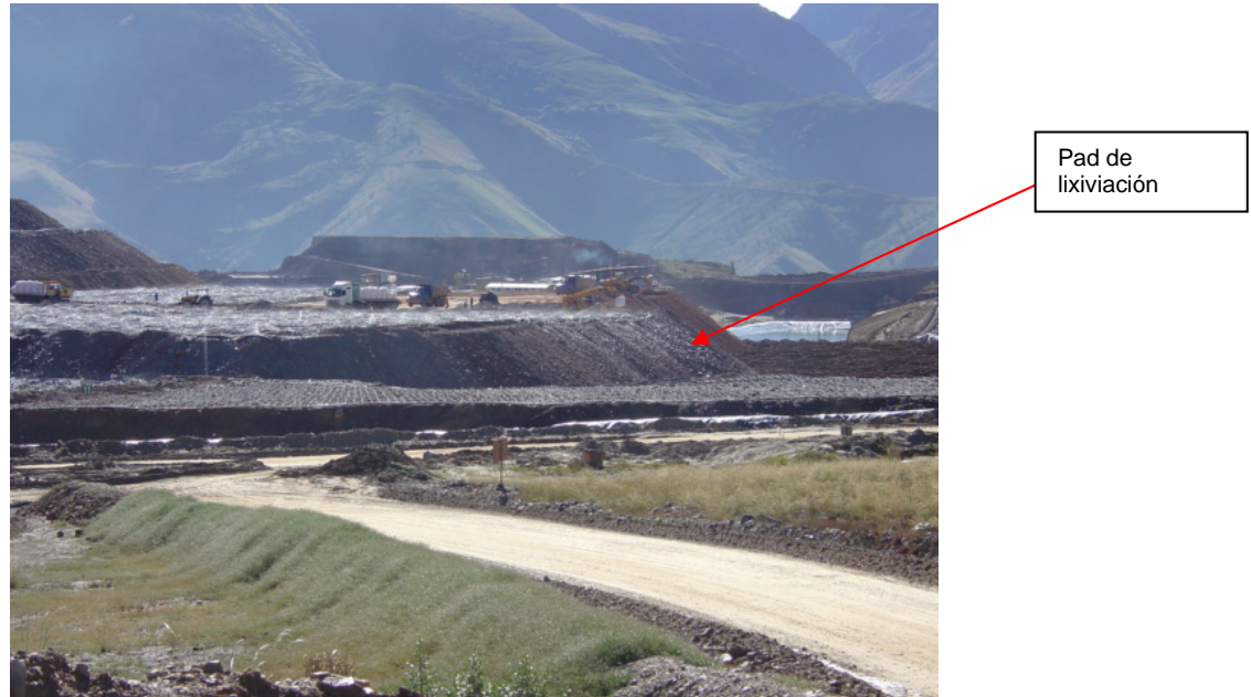
Fig. 22. Vista de los pads de lixiviación en pilas.(COMARSA)
