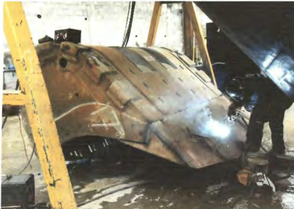
Figura 3.9 Reparación de cucharón de cargador de bajo perfil de 6 yd 3 Caterpillar.
