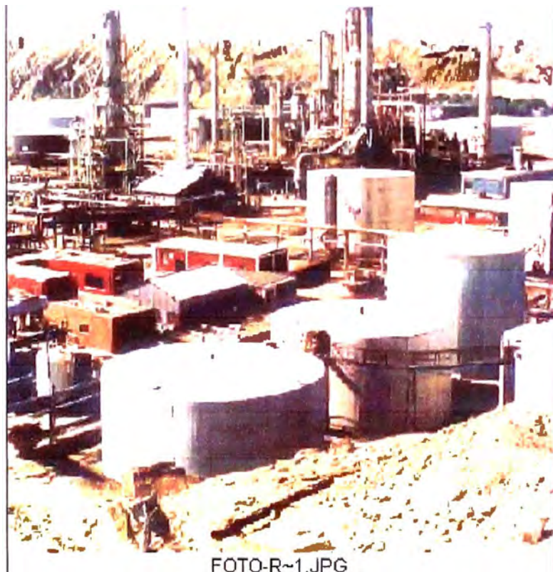
Figura 1.3. Vista de Refinería y patio de tanques.
