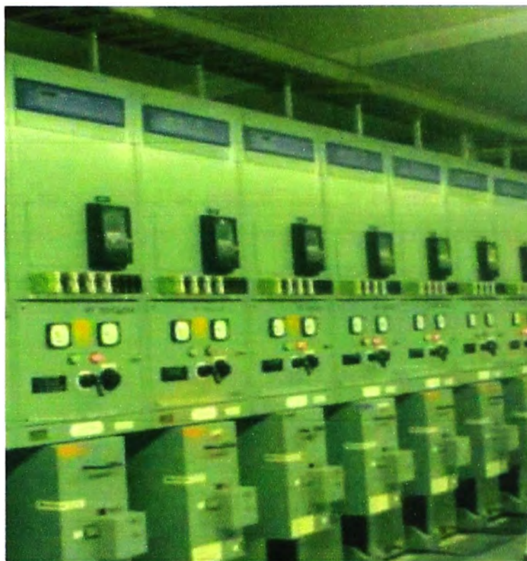
Fig. 3.16 Acabado final de las celdas de la barra III
