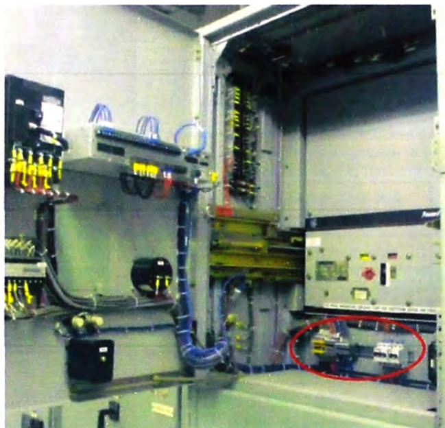
Fig. 3.9 Ubicación de Bornes en celdas superiores
