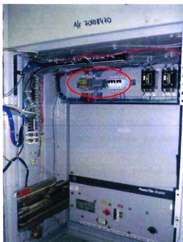
Fig. 3.10 Posición de bornera en celdas inferiores
