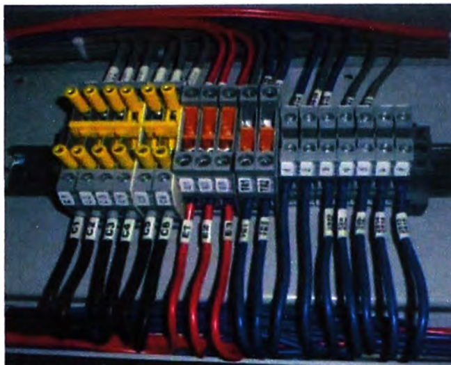
Fig. 3.12 Etiquetado de bomeras barra III
