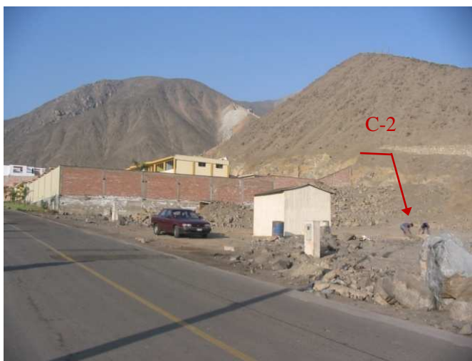
Foto 2.5 : Depósito coluvial ubicado en el Rincón de La Planicie en La Molina. El terreno se ha formado por el intemperismo de las rocas de los cerros circundantes y transporte por gravedad hasta depositarse en la parte plana, donde se ubican las viviendas y el pavimento.
