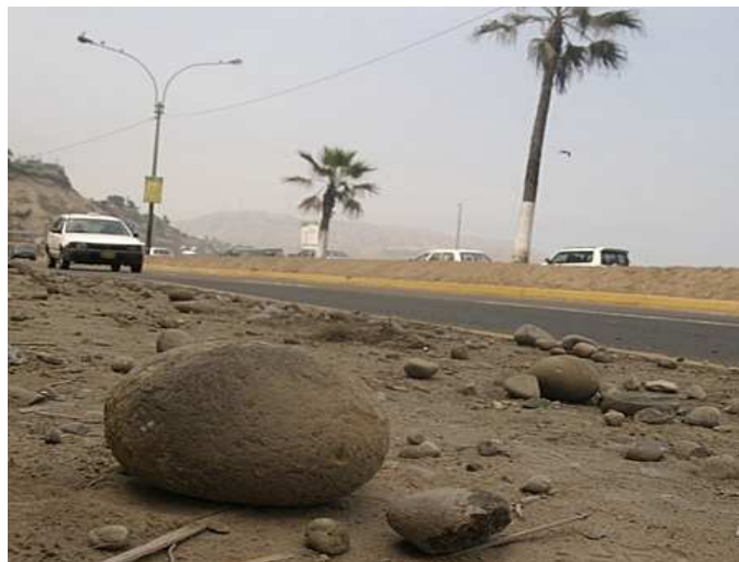
FOTO 5.3 Desprendimiento de cantos rodados del talud que llegan hasta la autopista.
