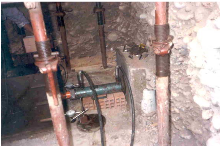
Foto 6.6 Muro de reacción para la aplicación de la fuerza horizontal
