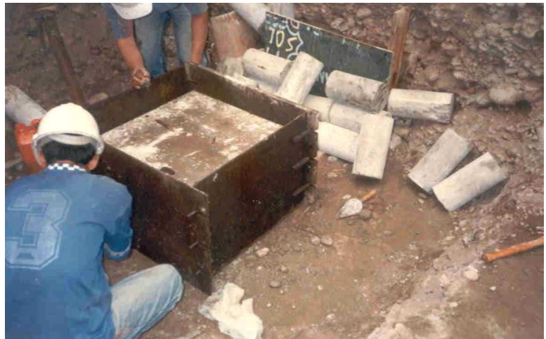
Foto 6.5 Colocación de las planchas de confinamiento
