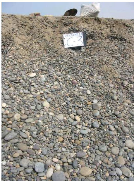
FOTO 7.6 Calicata C-3, excavada en forma de trinchera sobre la ladera de la terraza.
