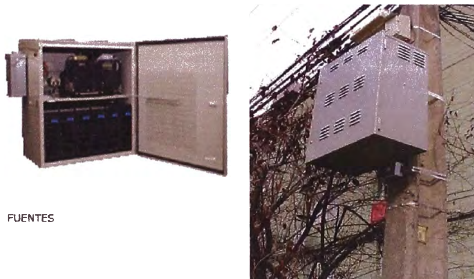
Figura 2.7 Fuente de poder de red HFC
