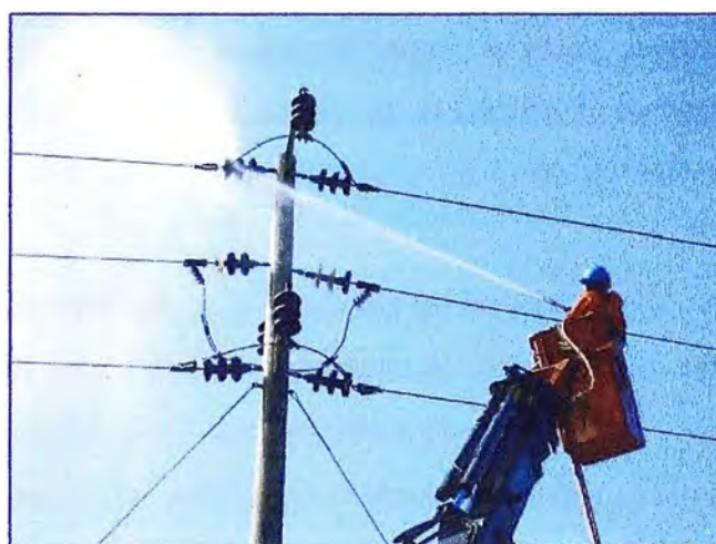
Figura N° 6.11 Hidrolavado de aisladores en líneas energizadas
