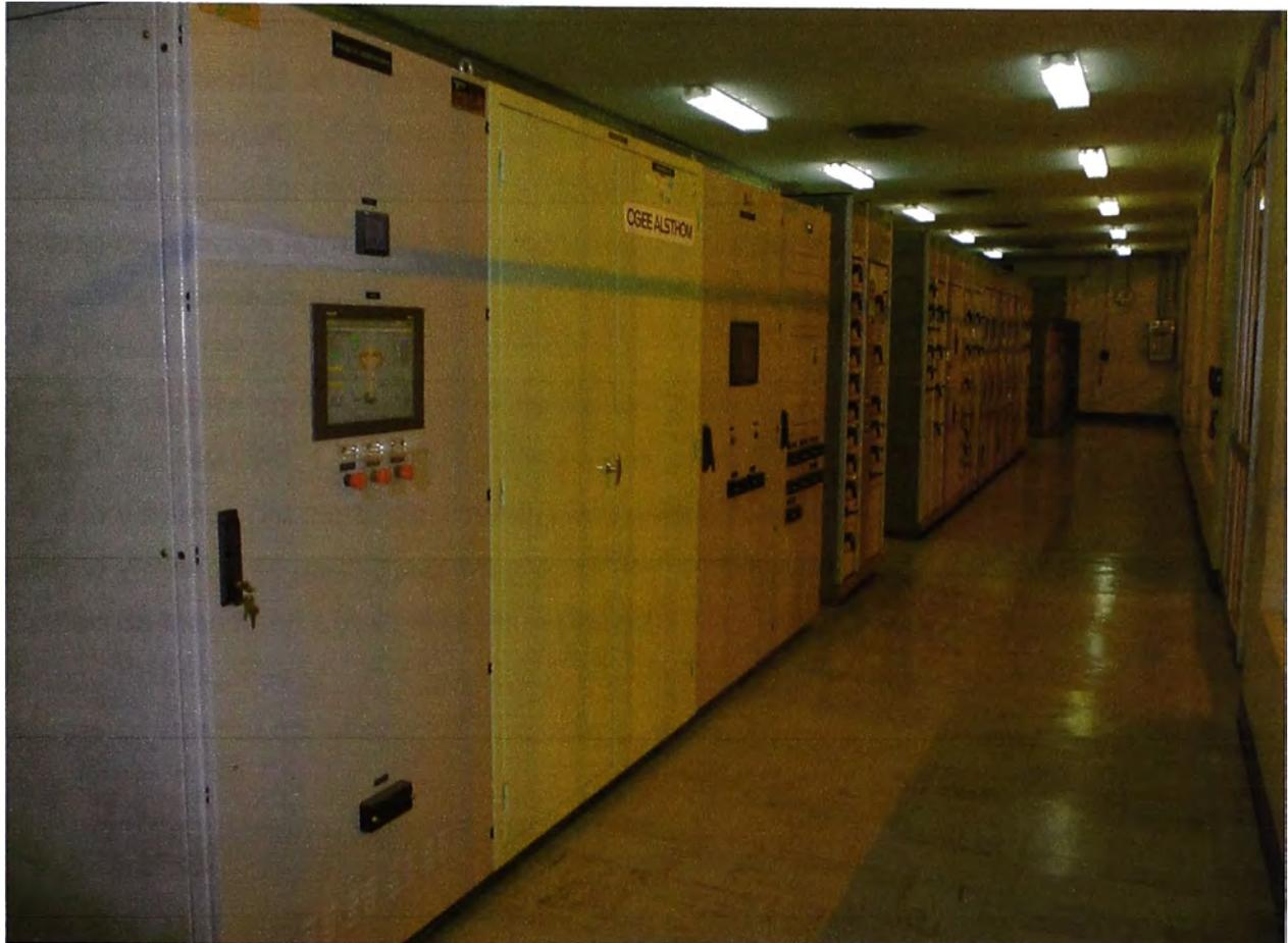
**Figura 1.16:** Tableros control (izquierda) y regulación (derecha) unidad generadora 1
