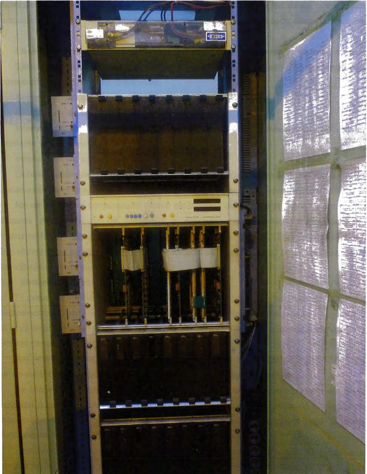
**Figura 1.1:** Tablero de control antiguo de la unidad generadora 1
