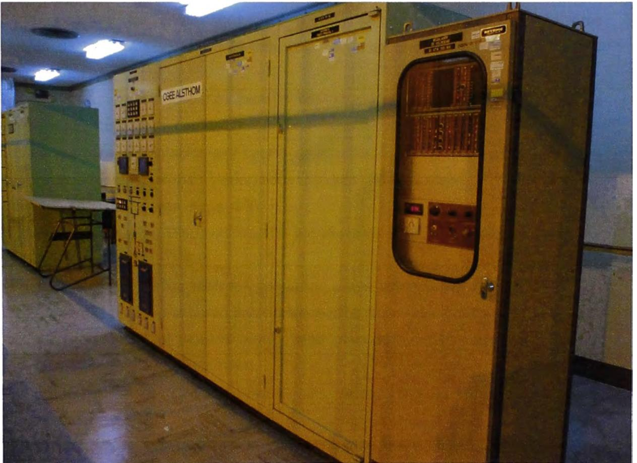
**Figura 1.13:** Tablero de señalización (izquierda) – Tablero de control (derecha)
