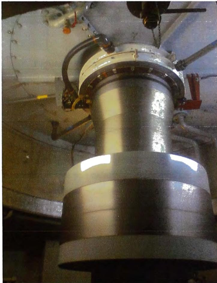
**Figura 1.4:** Eje turbina - generador de la central hidroeléctrica Charcani V
