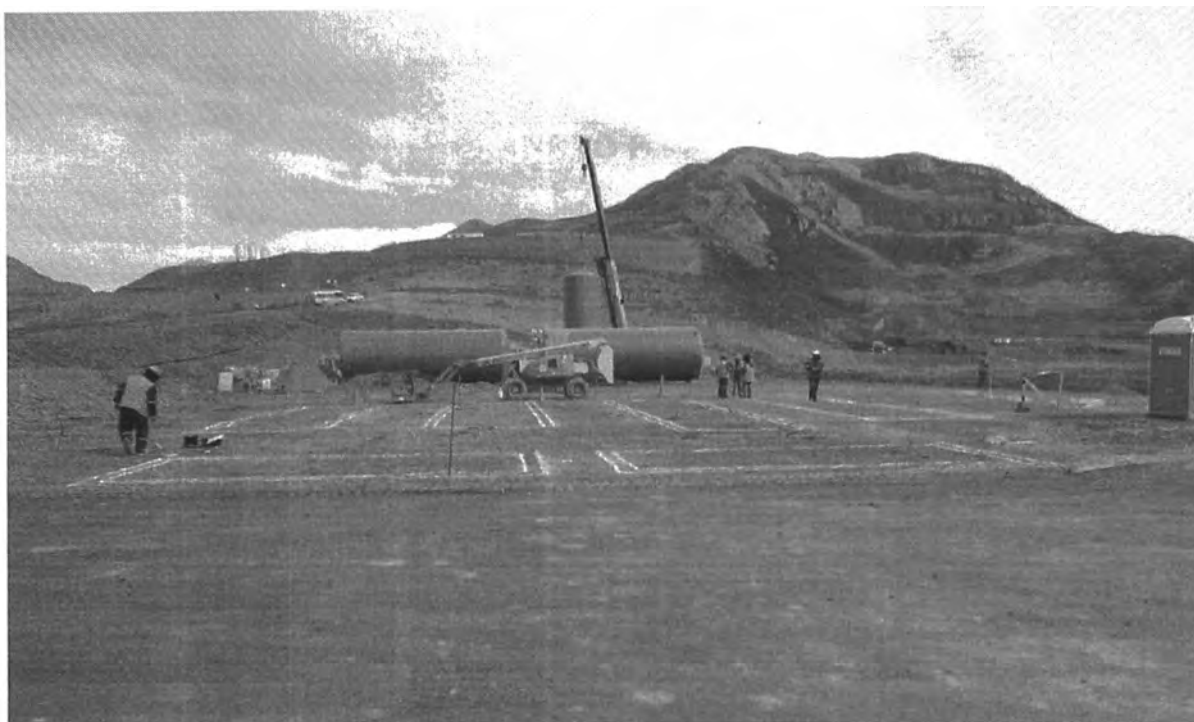
Foto 5- Vista del trazado de la planta de generación
