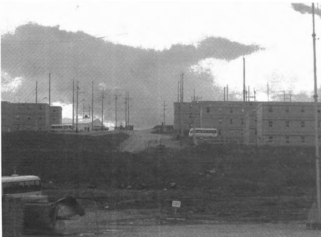
Foto 2- Vista de instalación de Pararrayos en el Campamento Tunshuruco
