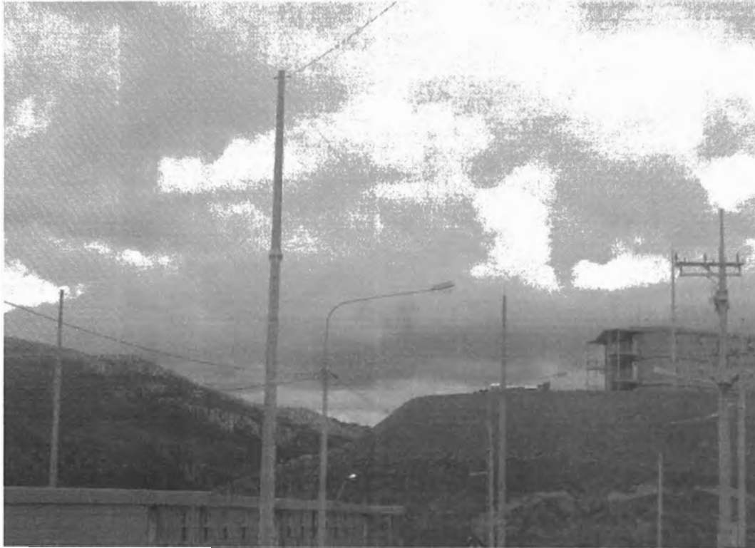
Foto 1- Vista de instalación de Pararrayos en el Campamento Tunshuruco
