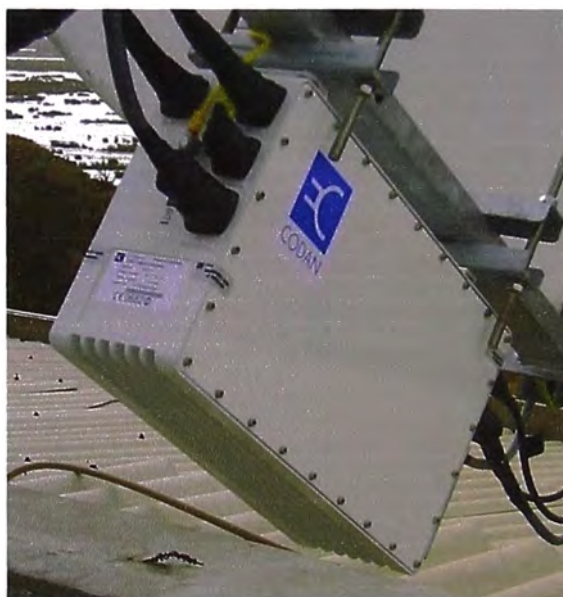
Figura 3.7 Equipo Converter Codan (Fuente: Propia)
