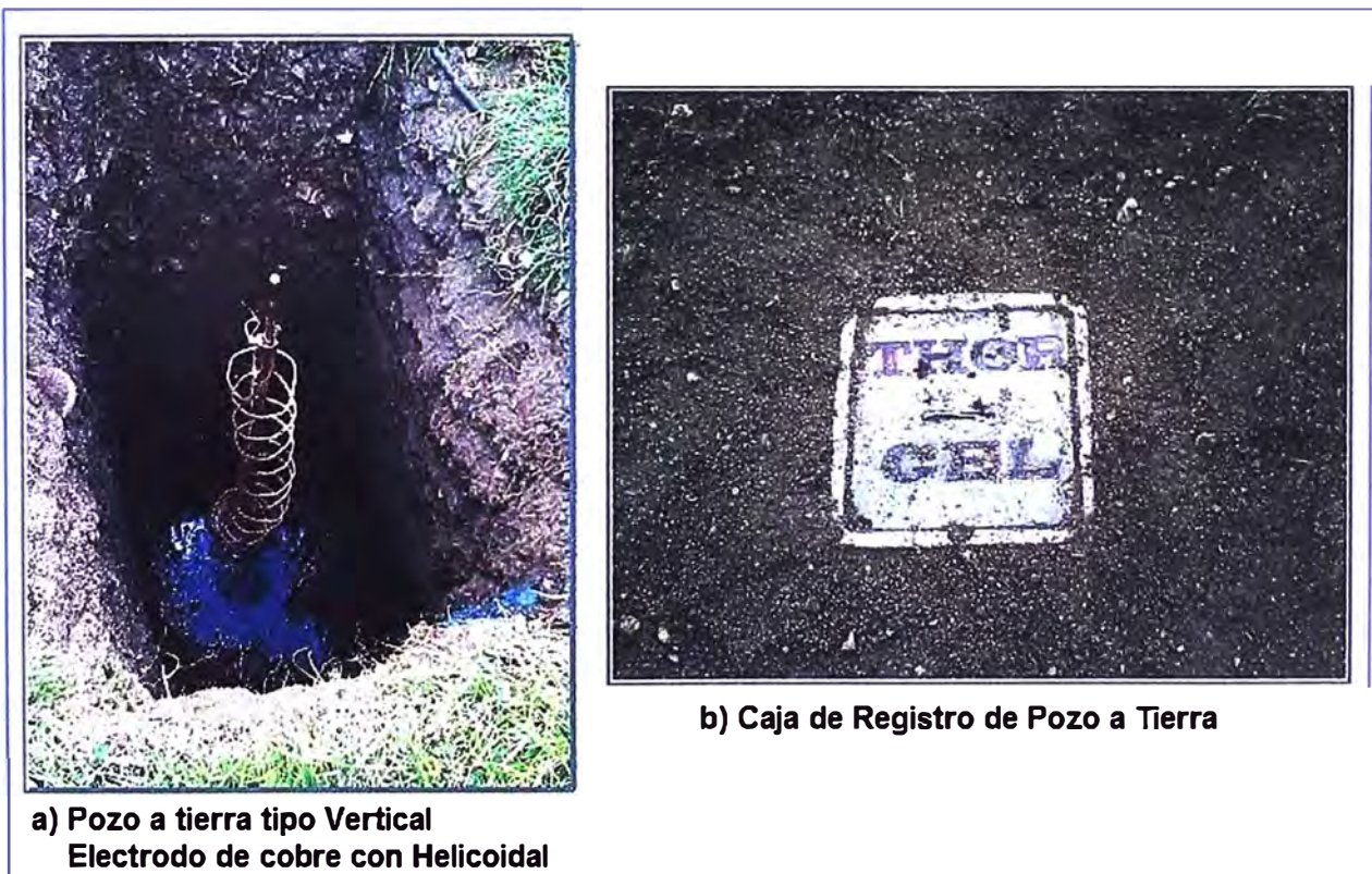
Figura 4.41 Instalación Pozo a Tierra sede Central Abancay
