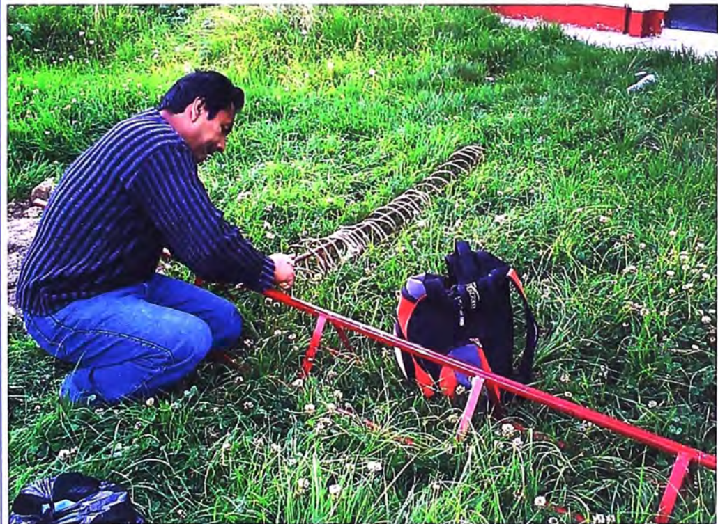
b) Preparando el electrodo de cobre con la Helicoidal
