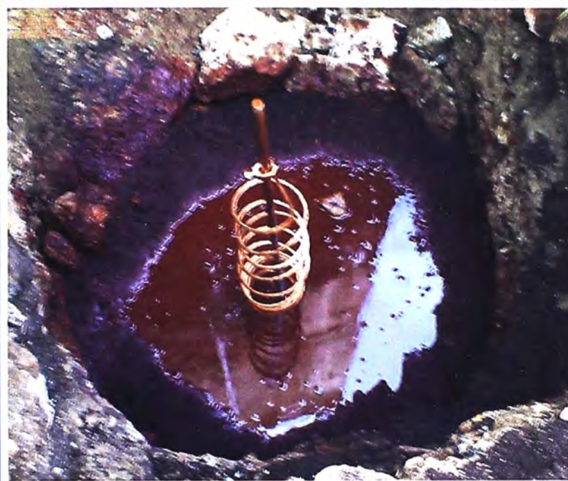
a) Pozo a Tierra con dosis de Thor Gel
