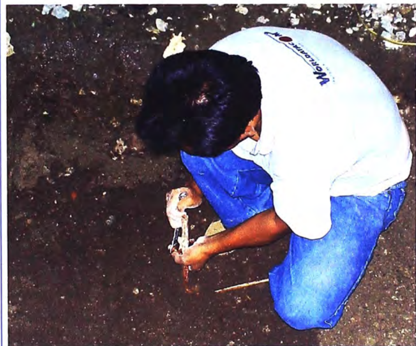
b) Asegurando conector a electrodo
