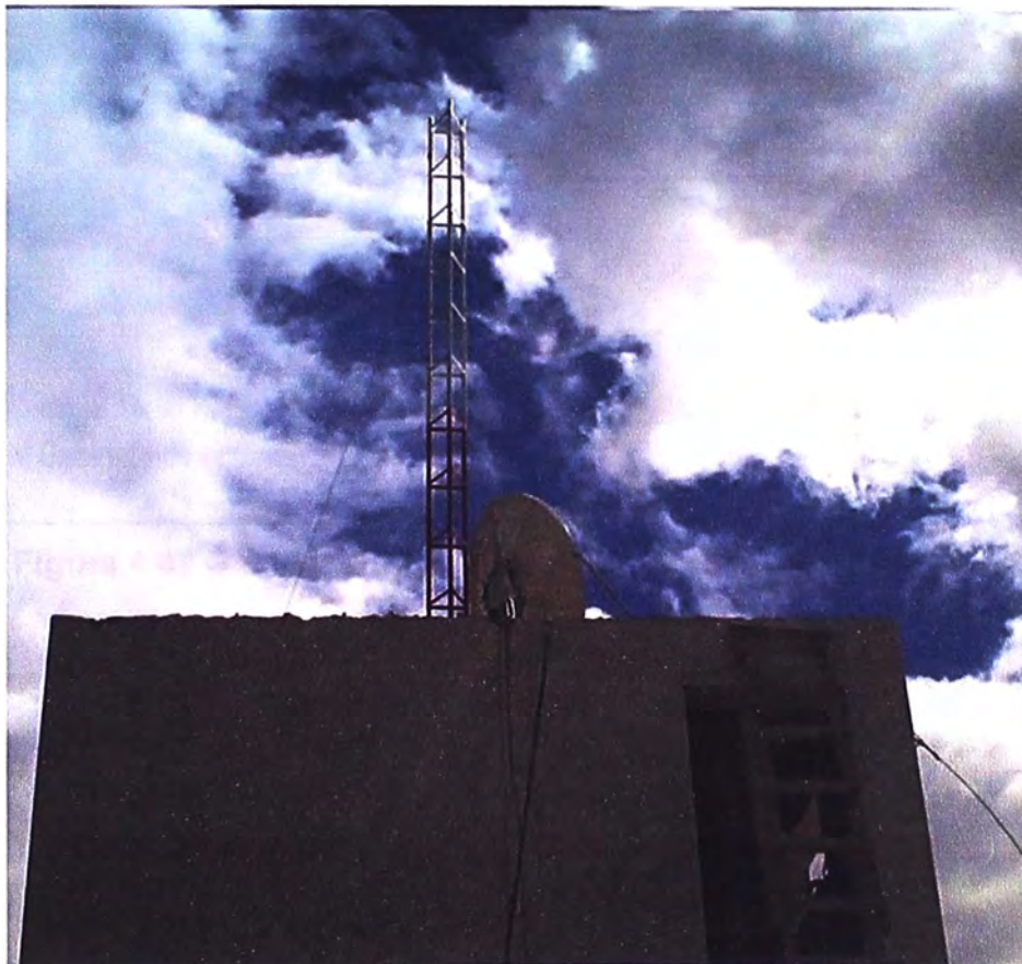
b) Instalación Torre en Azotea
