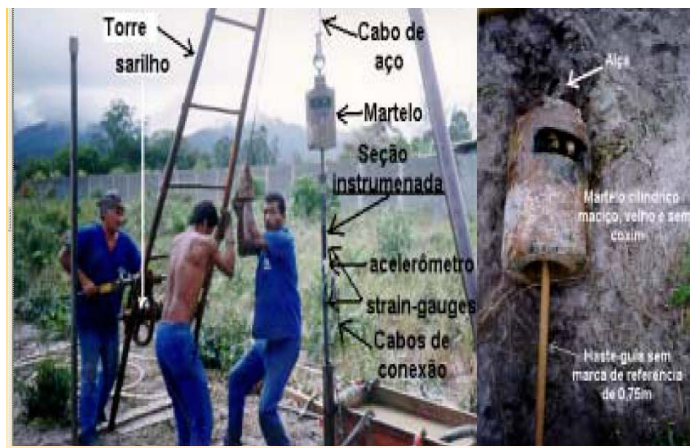
Foto N° 2.1.3 Equipo Analizador SPT. Se muestra el izaje del martillo y la ubicación de los acelerómetros y strain gauges.
