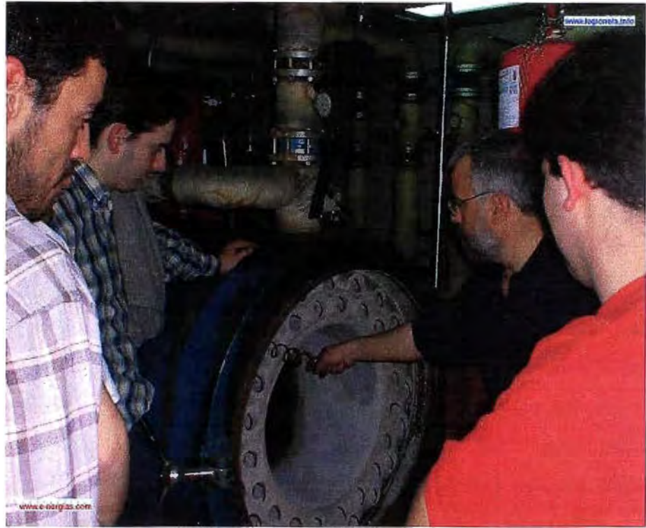
Figura N° 5.24: instalación de turbuladores en los tubos de combustión
