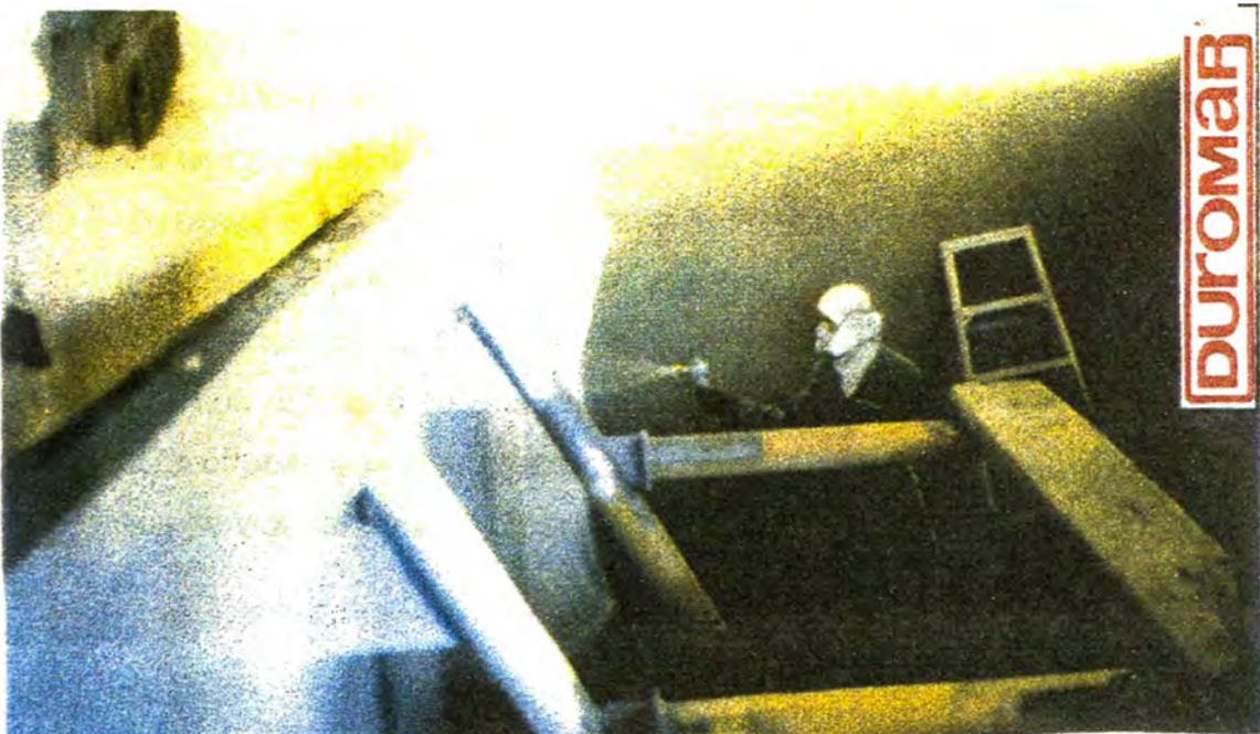
Foto 10B.- Aplicación con airless del HPK 2221.
