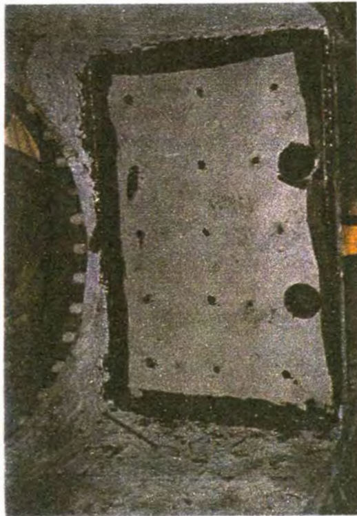
Foto N° 3B.- Inicio de reparación de la tapa de aleación de Acero.
