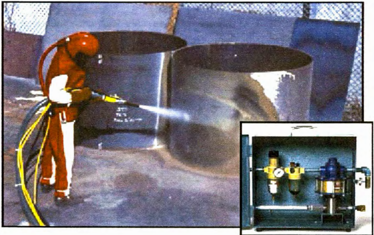
Foto N° 1A.- Sistema de arenado.
