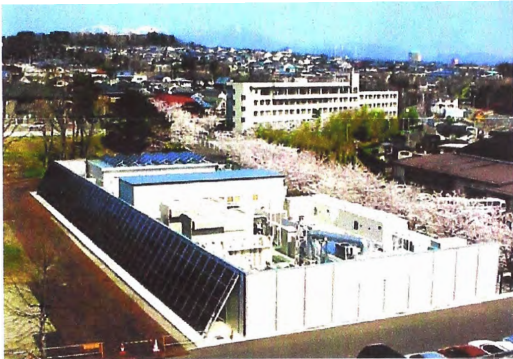
Fig. 8.4: Vista externa de la Generación distribuida de la microrred de SENDAI, Japón
