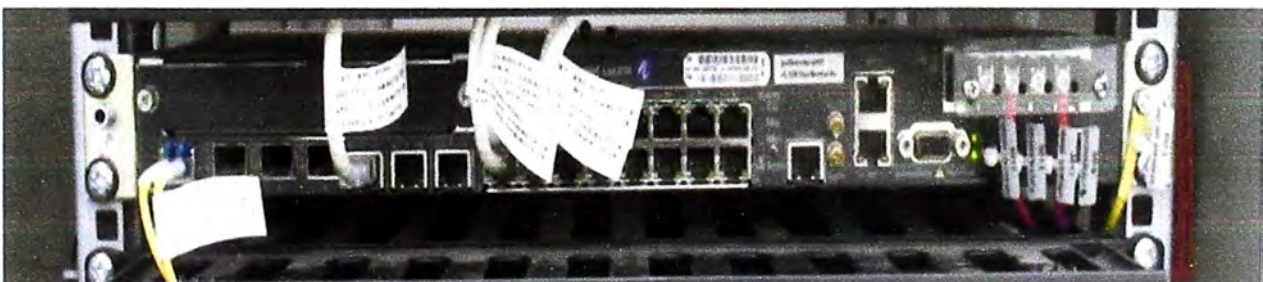
Figura 3.12 Equipo de Acceso 7705 SAR-M – Con Puertos Disponibles (Fuente: Propia)
