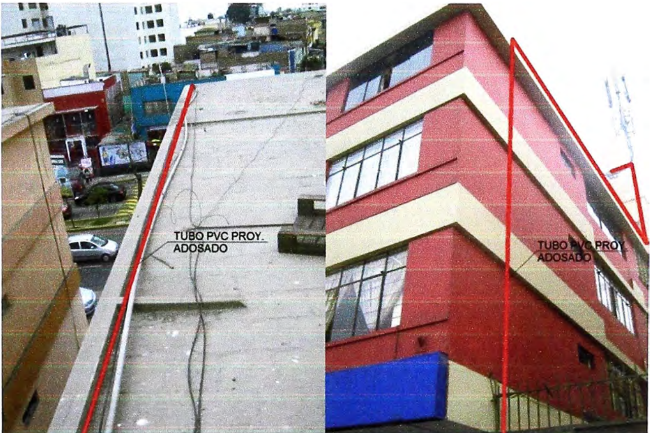
Figura 3.22 Recorrido de FO en Estación Base (Fuente: Elab. Propia)
