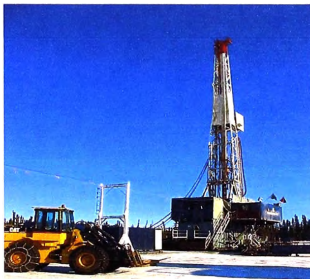
Figura 2.4 Torre de perforación
