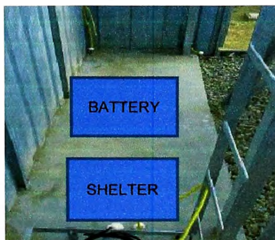
Figura 3.3 Área reservada para Gabinete Shelter y de batería (Fuente: Elab. Propia)
