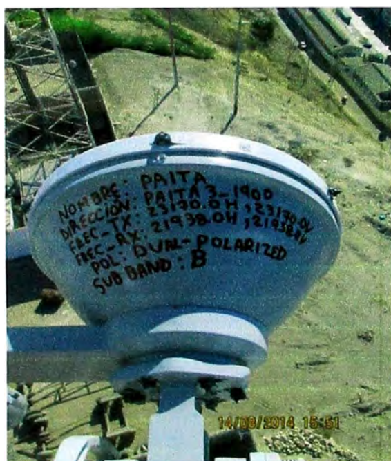
Figura 3.16 Antena en el Site Paita con dirección a Paita_3_1900 (Fuente: Elab. propia)
