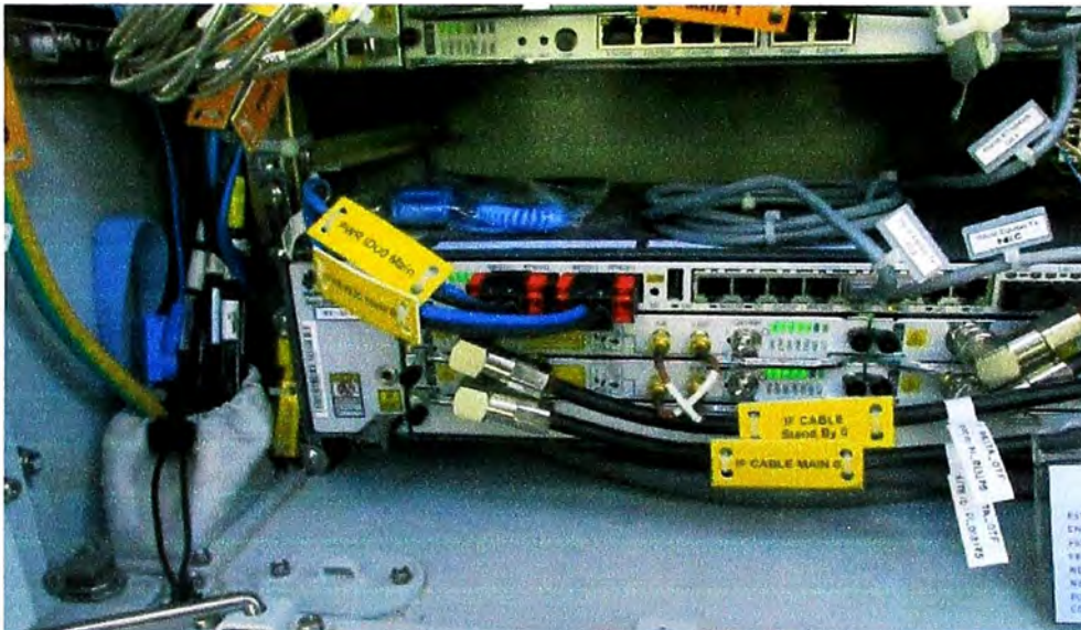
Figura 3.18 conectores XPIC a las tarjetas ISV3 (Fuente: Elab. Prop.)
