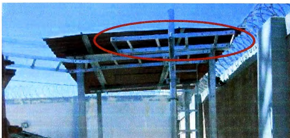
Figura 3.14 Escalerillas: a) Horizontal (Elevadas)) (Fuente: Elab. Propia)
