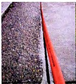
Figura 4.13 Instalación del ducto vertical en la microzanja (Fuente Ref. [5])
