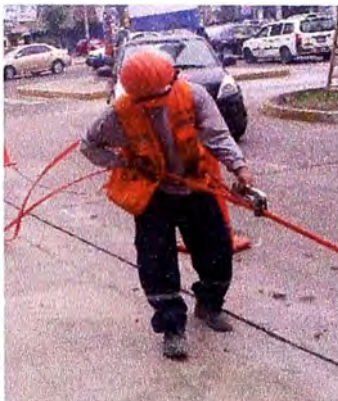
Figura 4.12 Unión de canaletas (Fuente: Elab. Propia)
