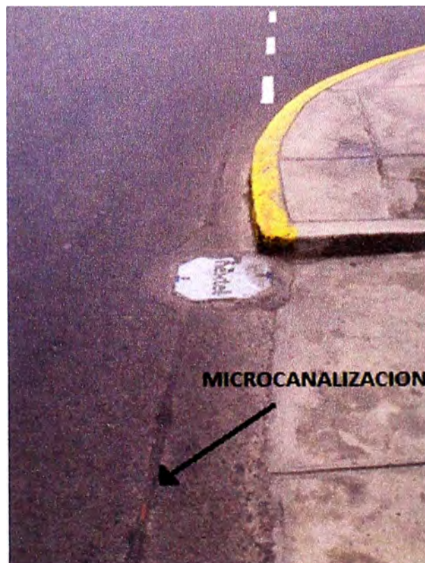
Figura 4.15 Resane de la microcanalización (Fuente: Elab. Propia)
