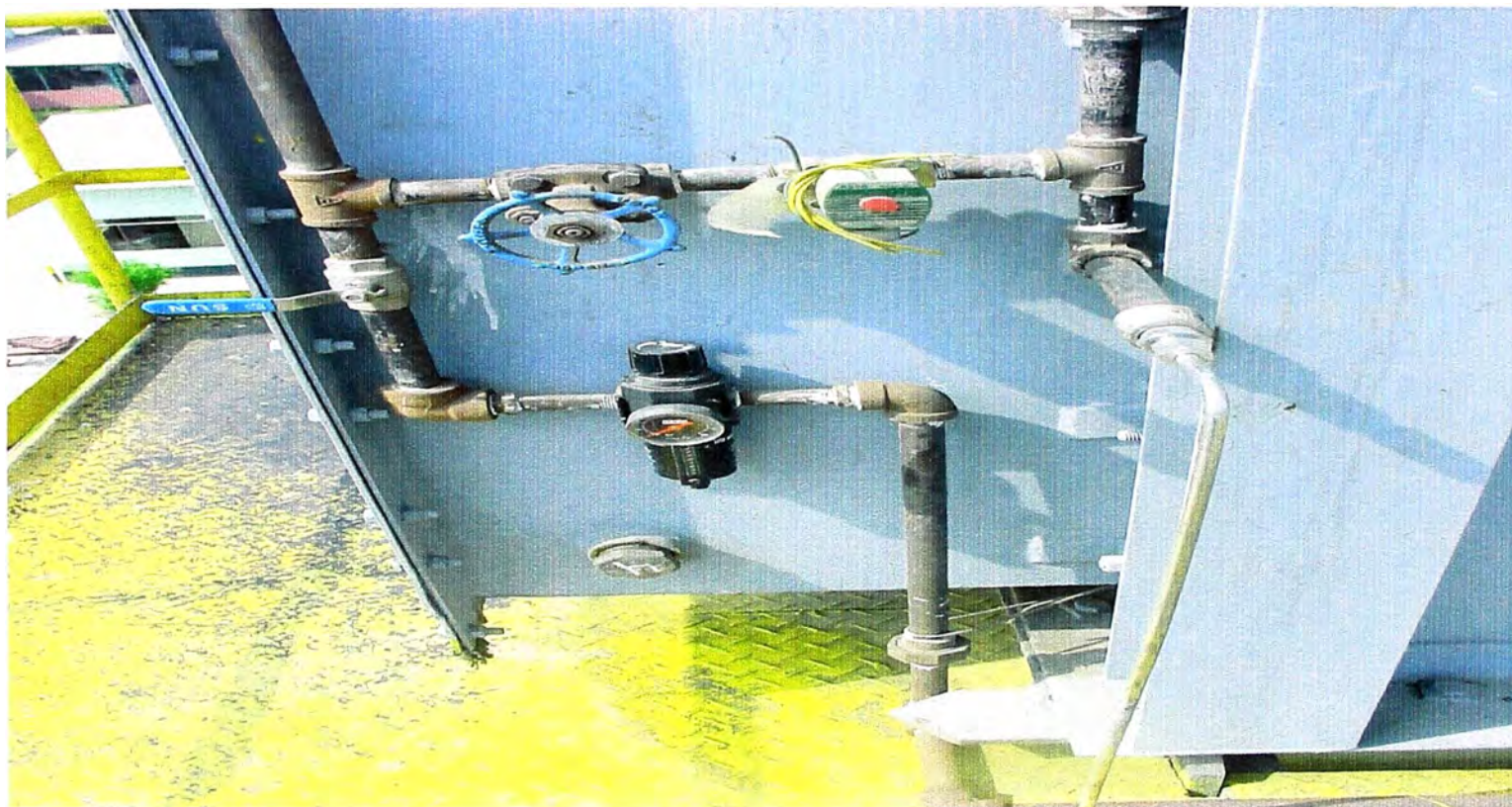
Fotografía N°18: RED DE SUMINISTRO DE AIRE PARA CONTROL DE PROBETA MANUAL EN ZONA CONVECTIVA HORNO F-1.
