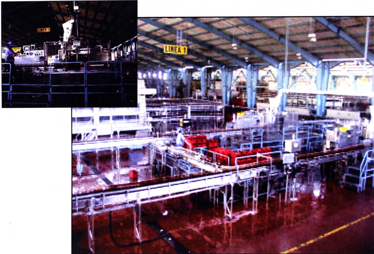
Fig. 15 Sala de Envasado ( central) y detalle de la llenadora ( superior izquierda)
