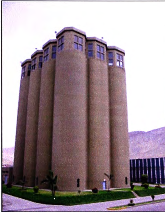
Fig. 8 Silos de Malta y Maíz
