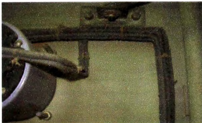
Figura 4.10 Cables reemplazados en la Celda del Circuito N°03
