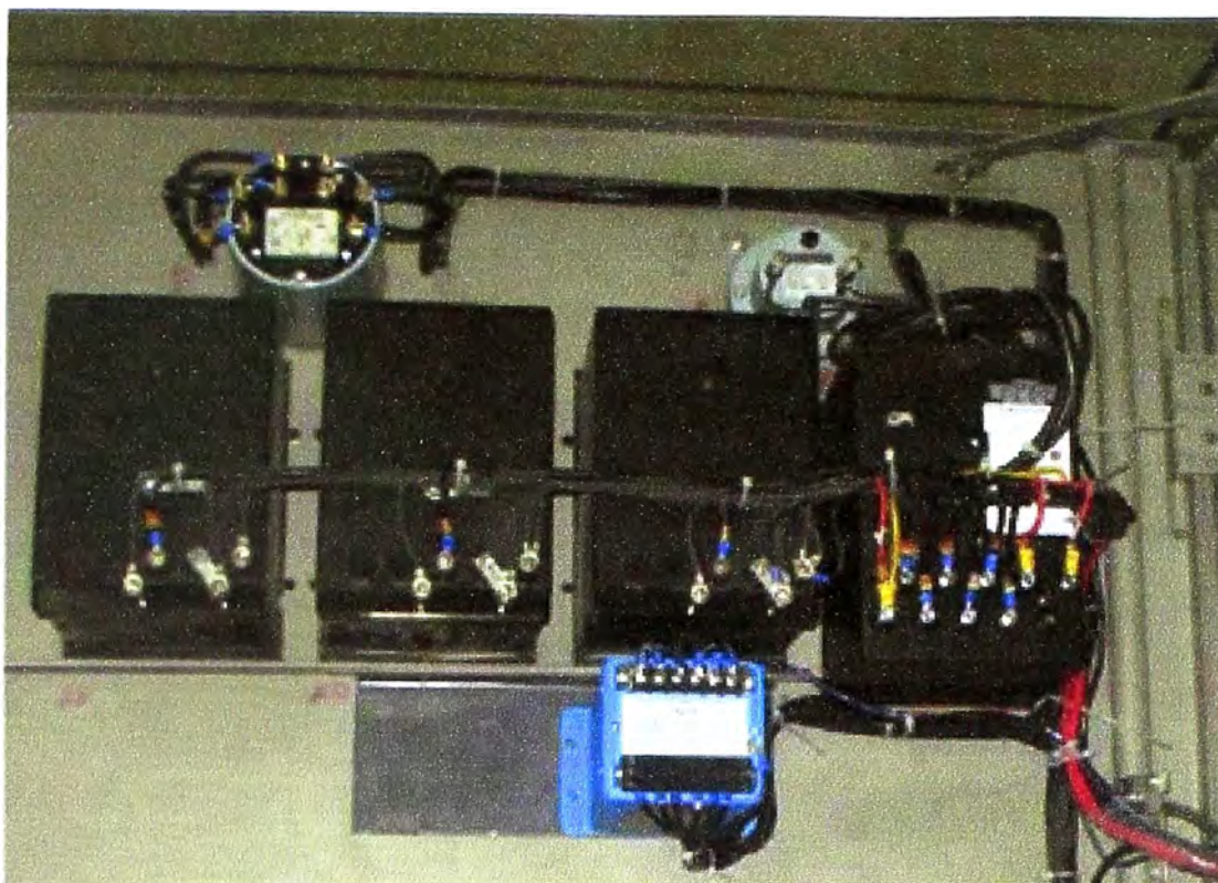
Figura 4.11 Acabado final de la Celda del Circuito N°03
