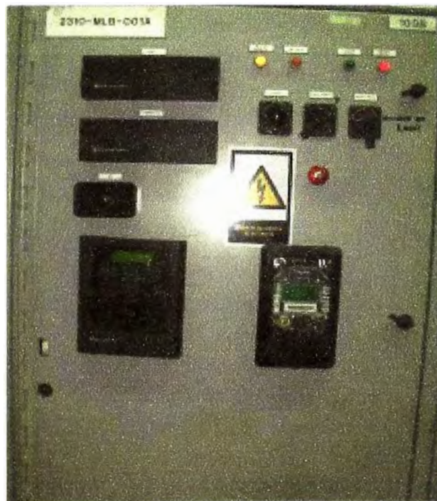
Figura 4.6 Instalación del nuevo medidor.
