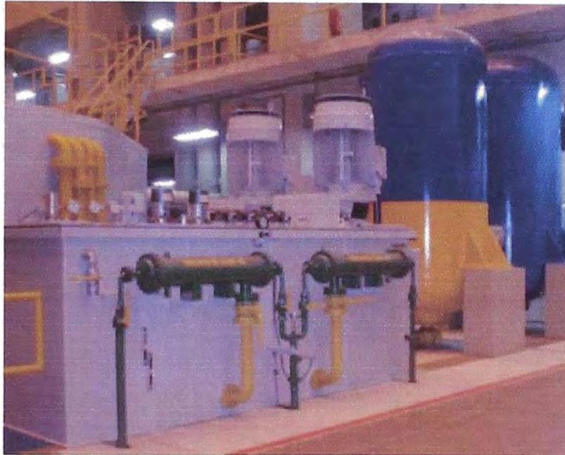
Figura 6.4- Sistema de regulación de velocidad.
