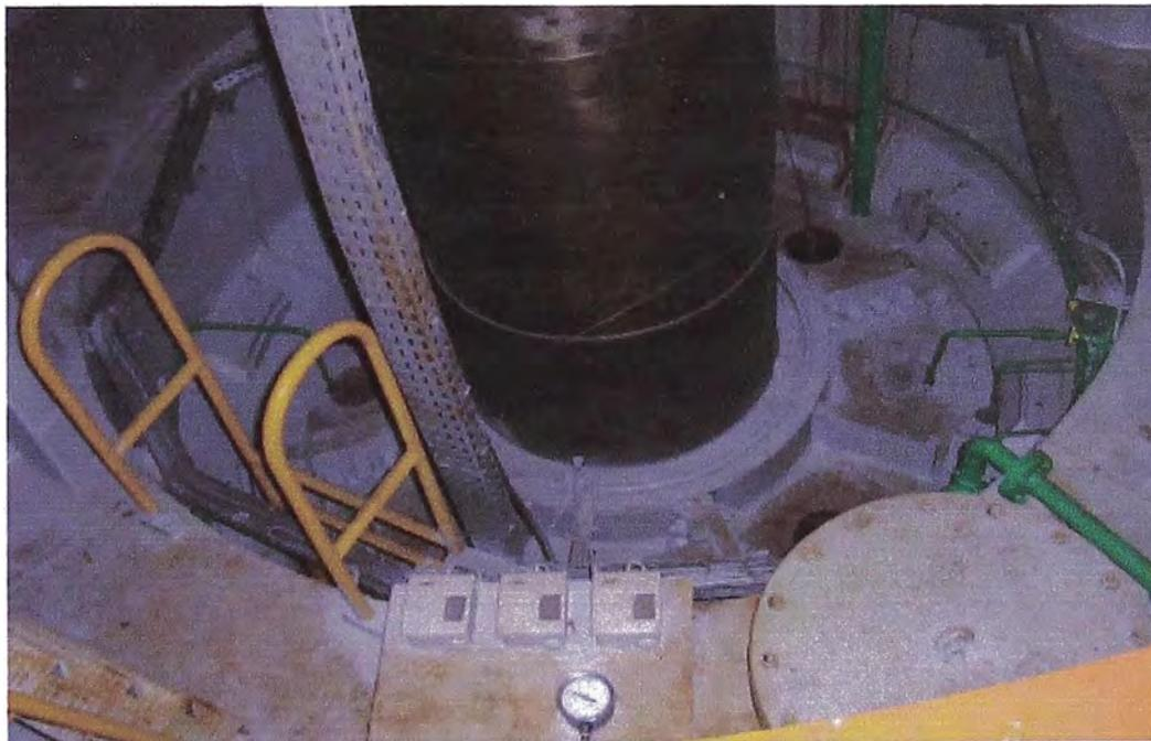
Figura 6.3- Eje y mancal guía de la turbina.
