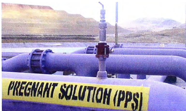
CUPÓN DE INCRUSTACIÓN INSTALADO EN LINEA DE SOLUCIÓN A ADSORCIÓN
