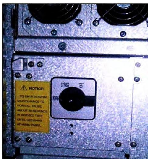
**Figura 2.2 Bypass manual utilizado en los equipos General Electric**
