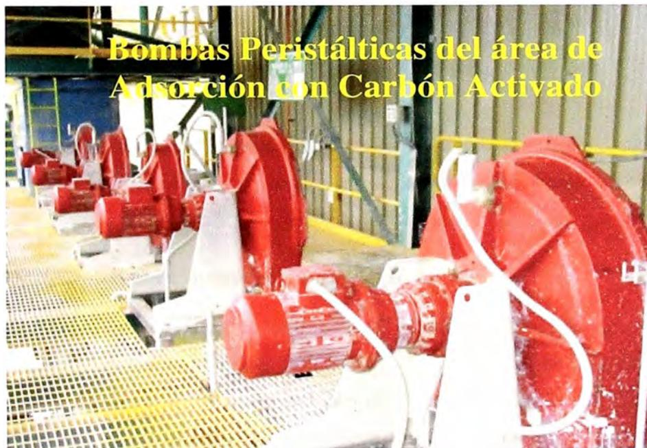
Fotografía N° 7: Se observa las Bombas Peristálticas del área de Adsorción
