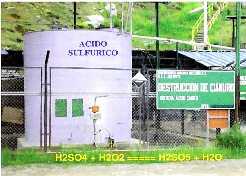
Fotografía N° 12: Tanque para Ácido Sulfúrico para la formación del Ácido Caro
