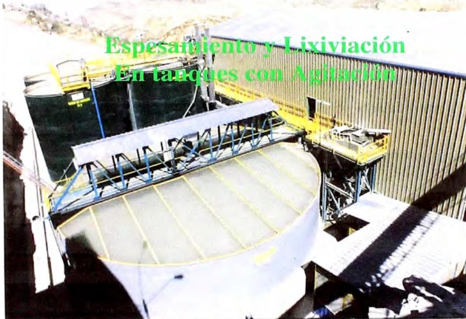
Fotografía N° 6: Se observa el Espesamiento y Cianuración de la Pulpa
