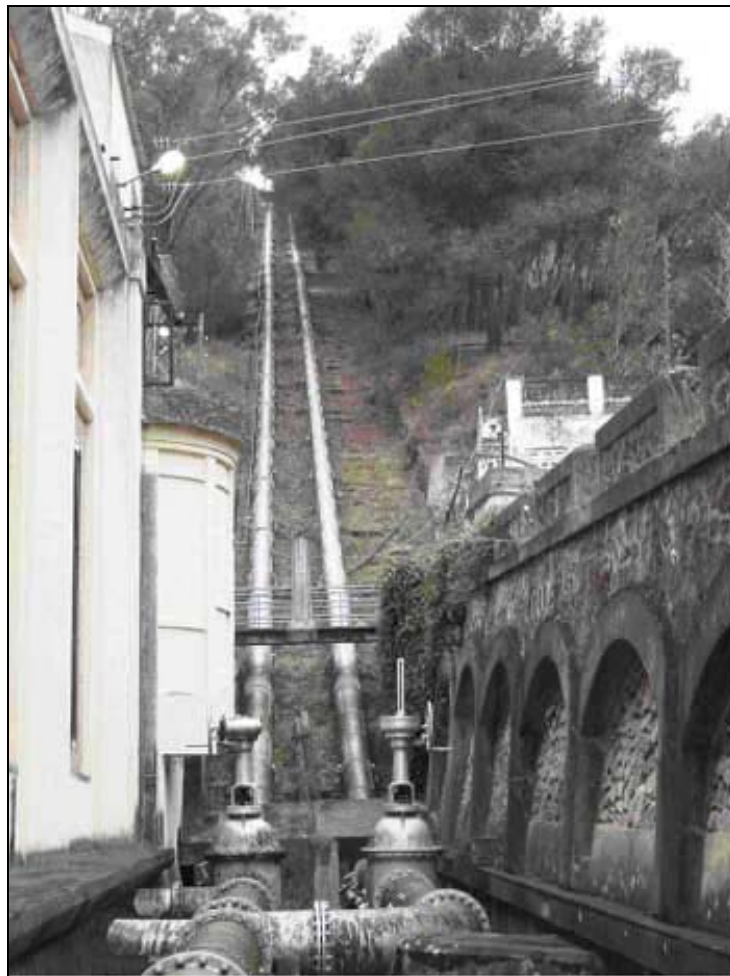
Fig.2.10. Tubería forzada de la Central Hidroeléctrica San Augusto (España)
