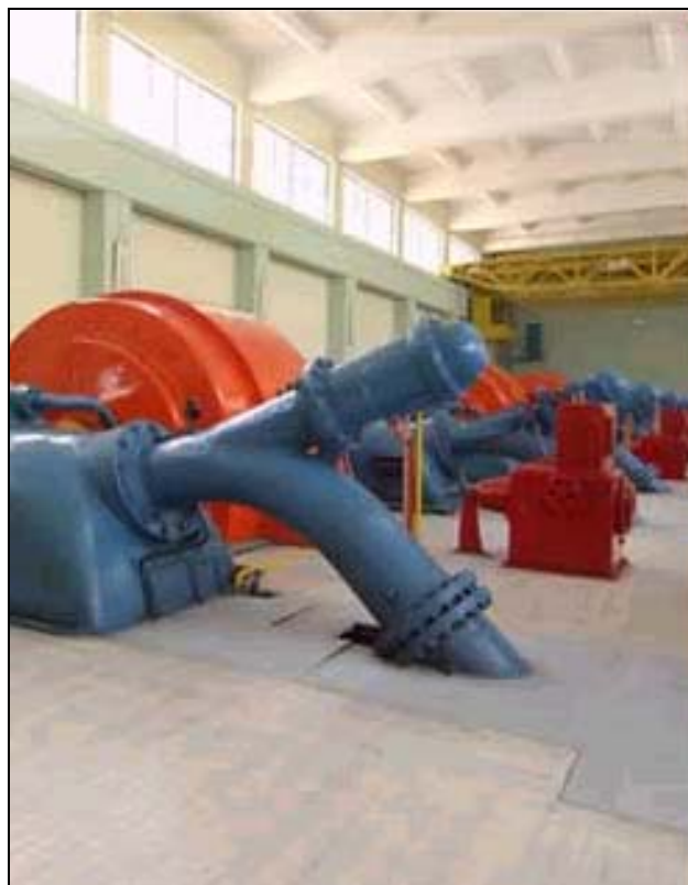
Fig.2.15. Casa de Máquinas
