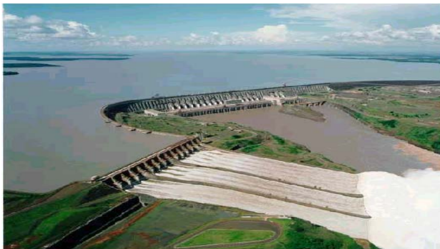
Fig.2.2. Central Hidroeléctrica de Itaipú
