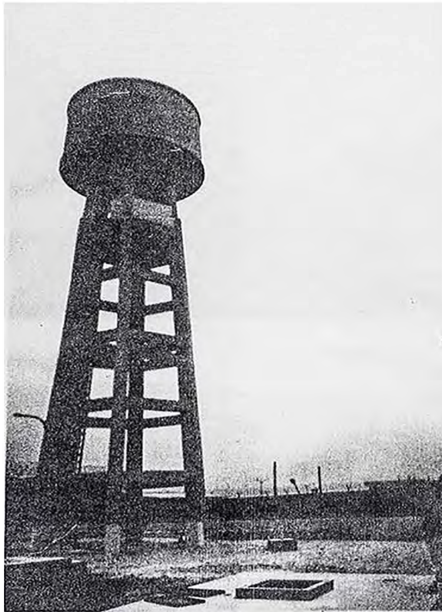
Servicios Complementarios: Tanque y caseta de Bombeo.
