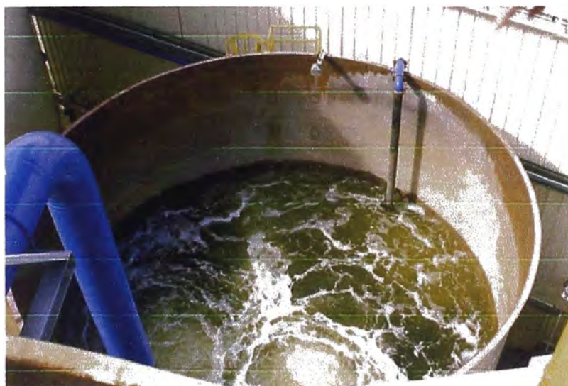
Figura 3.7 Foto del tanque de solución Barren en la planta de Merrill Crowe
