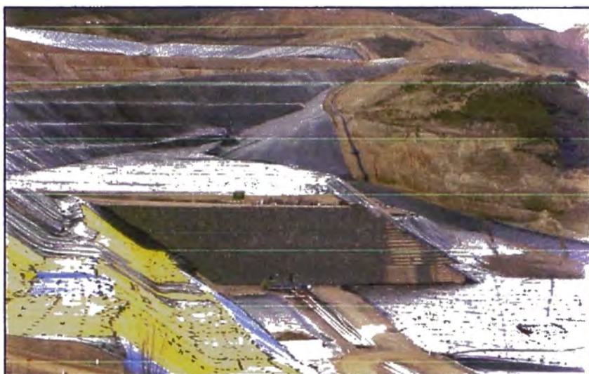
Figura 3.3 Foto de una pila de lixiviación forrada con liner
