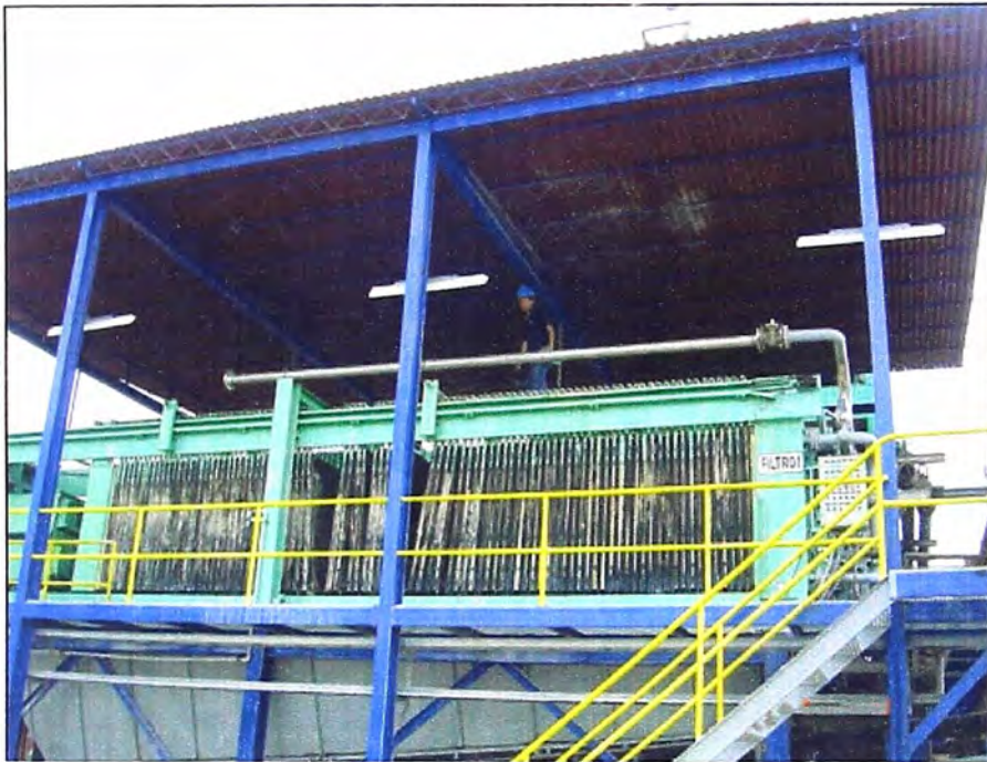
Figura IV.7 Puesta en marcha de filtro de Lodos
