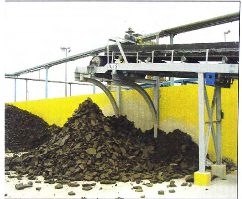
Figura IV.8 Descarga de torta filtrada
