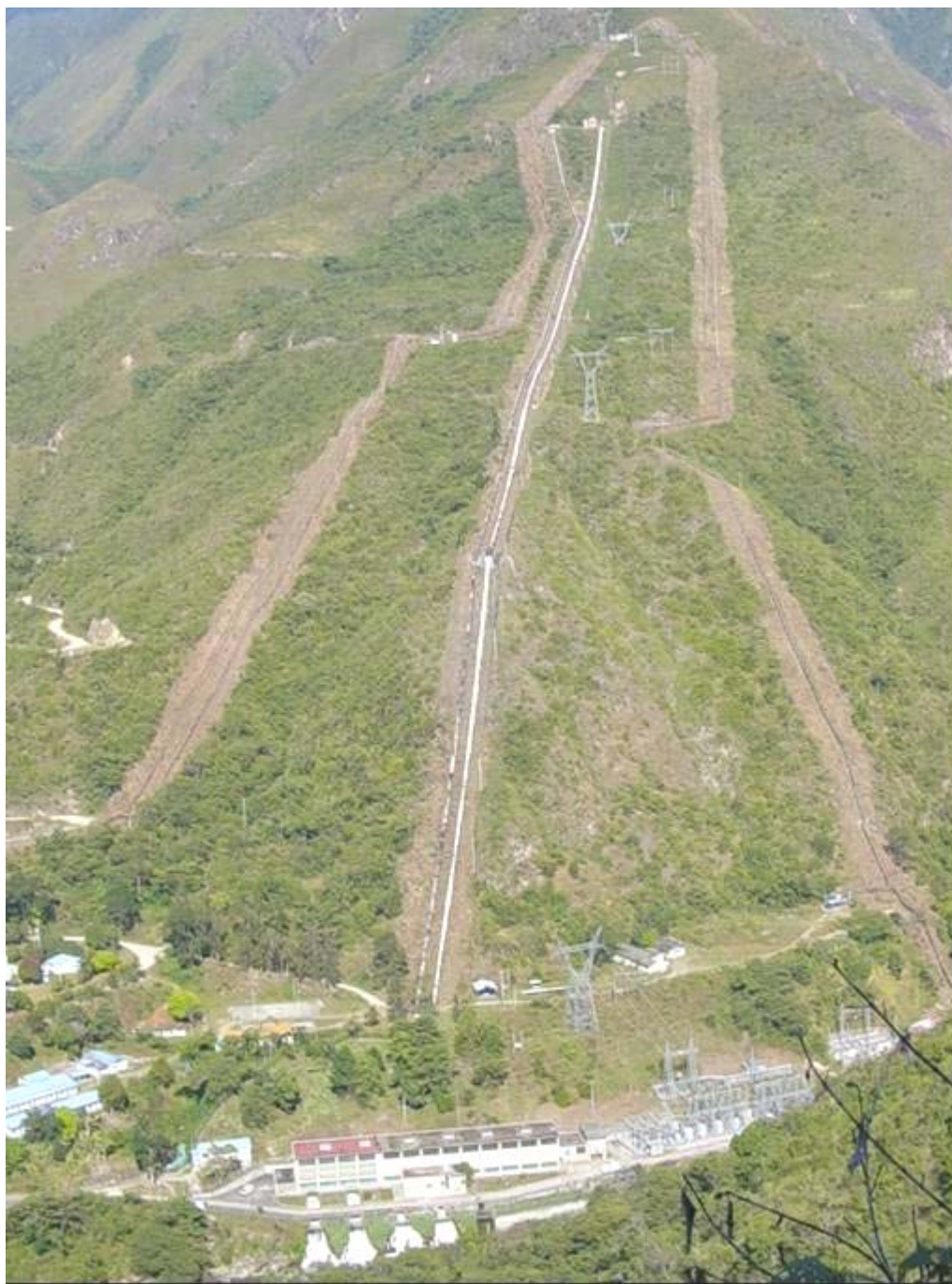
Foto panorámica de las Tuberías Forzadas
