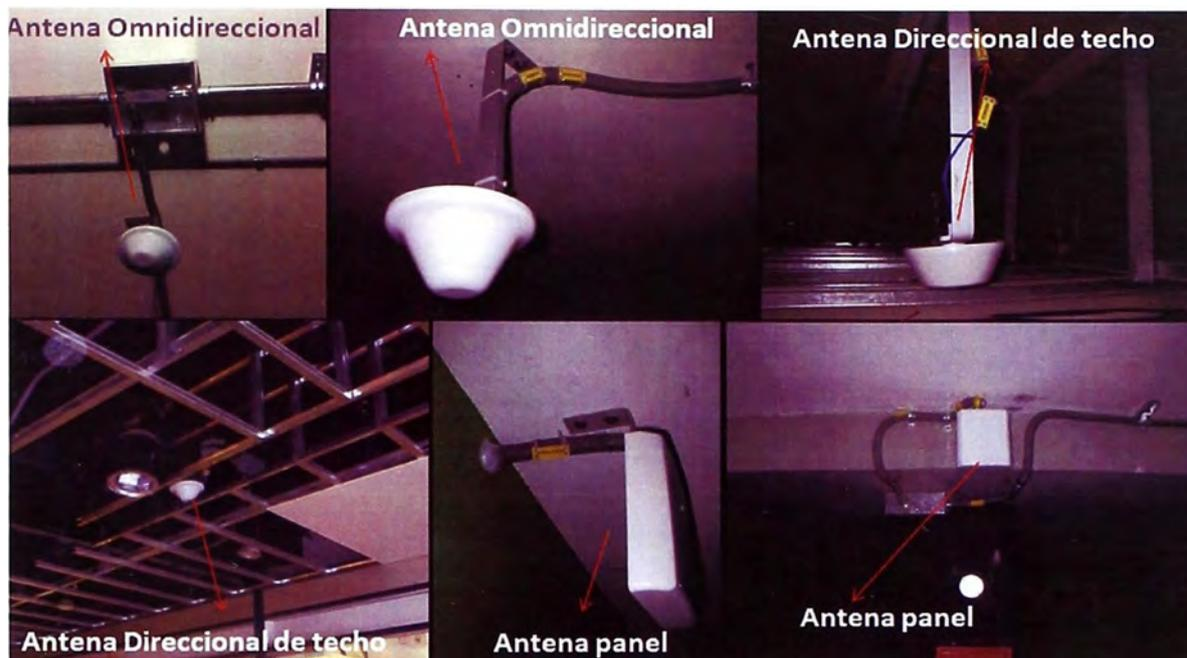
**Figura 3.12** Ejemplo de antenas instaladas (Fuente: Elab. propia)
