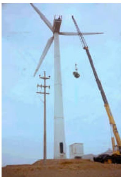
GENERADOR EÓLICO DE MALABRIGO 250 Kw.
