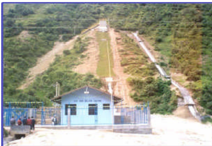
MINICENTRAL HIDROELÉCTRICA SAN BALVÍN 2 x 140 Kw.
