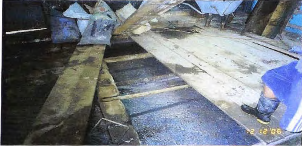
Foto: Pozas de tratamientos de efluentes.
