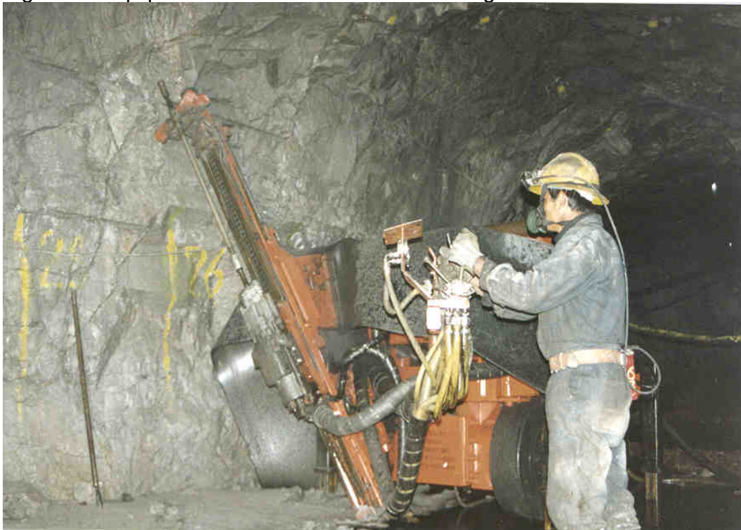
Figura 6.- Equipo de Perforación de Taladros Largos
