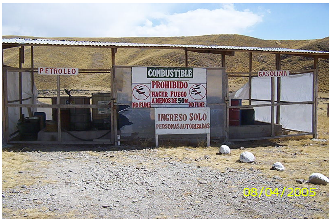
Foto 6: El área para el almacenamiento de combustible, aceite y grasas debe estar cercada, con una adecuada señalización y mostrar las hojas de seguridad MSDS de los materiales.
