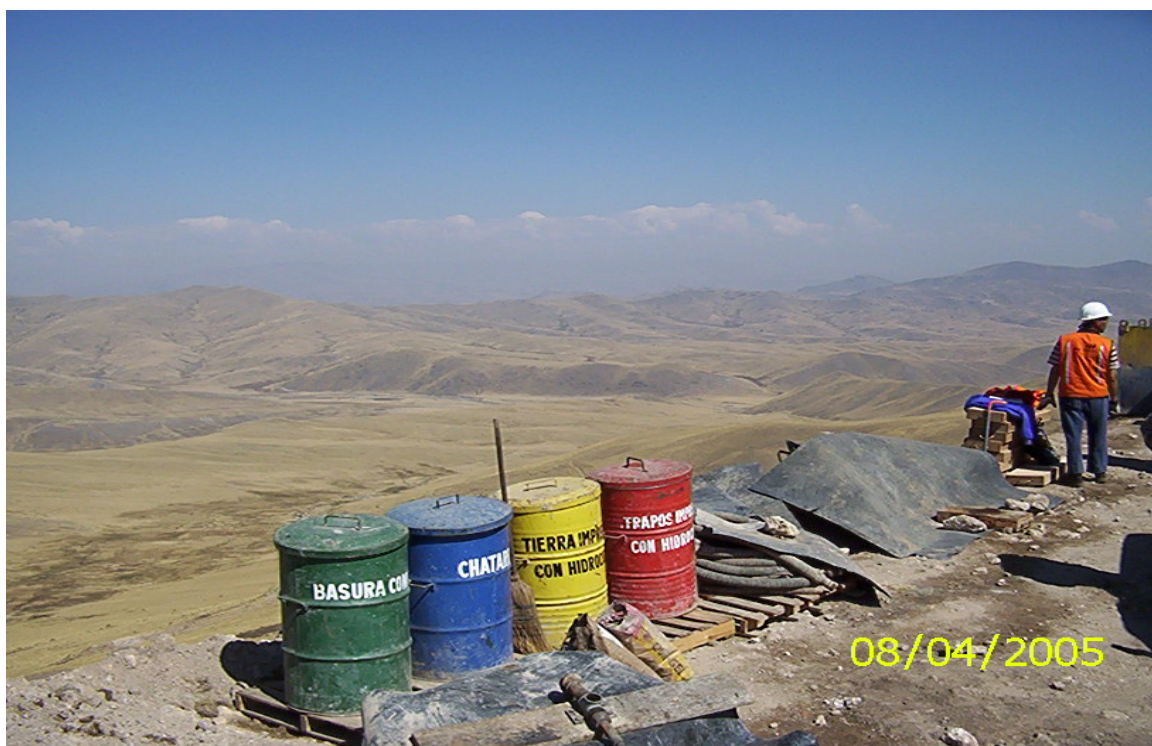
Foto 5: Es importante disponer de cilindros pintados y rotulados para la adecuada disposición de los residuos que se generen.
