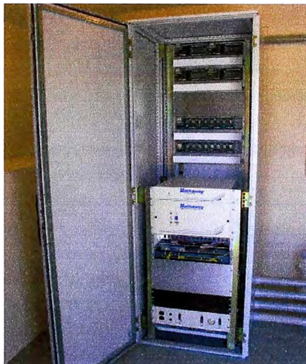
Fig. 1.7 Sistema de Automatización de Subestación Secundaria
