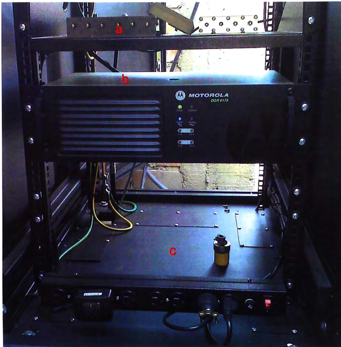
Figura E.2 Detalle de vista frontal de gabinete. a) duplexor, b) repetidor MOTOTRBO, c) Tomas de corriente múltiple
