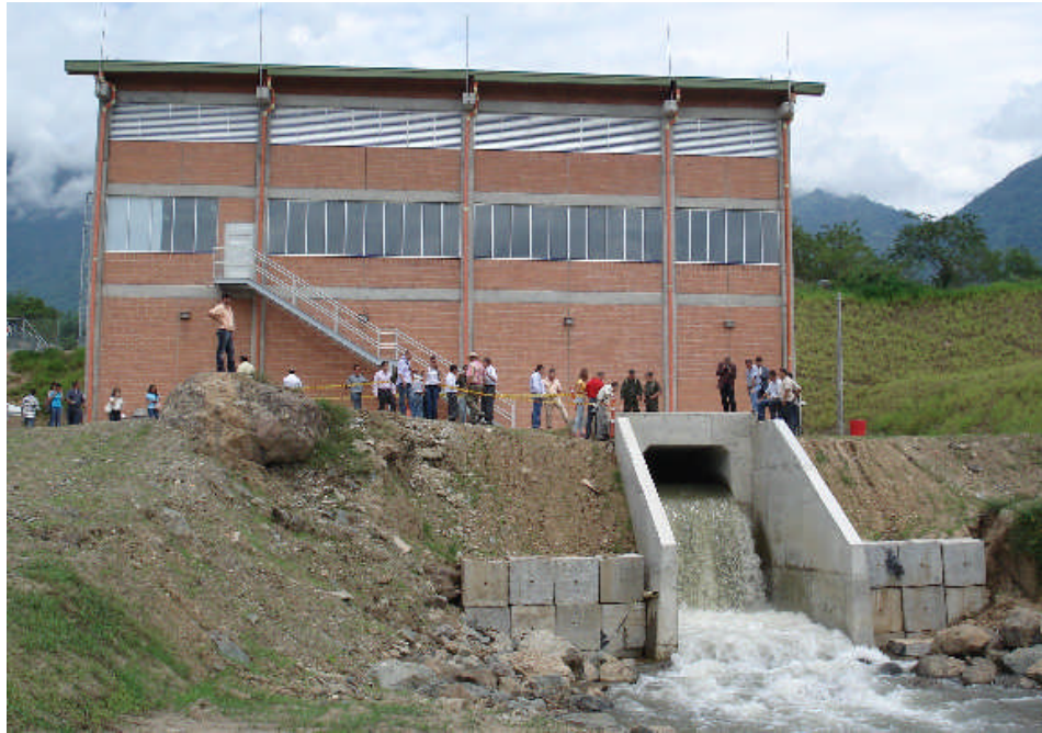
Casa de maquinas
