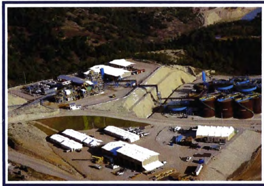
Figura 2.4.-Mina de Oro MERLIN - Guatemala
