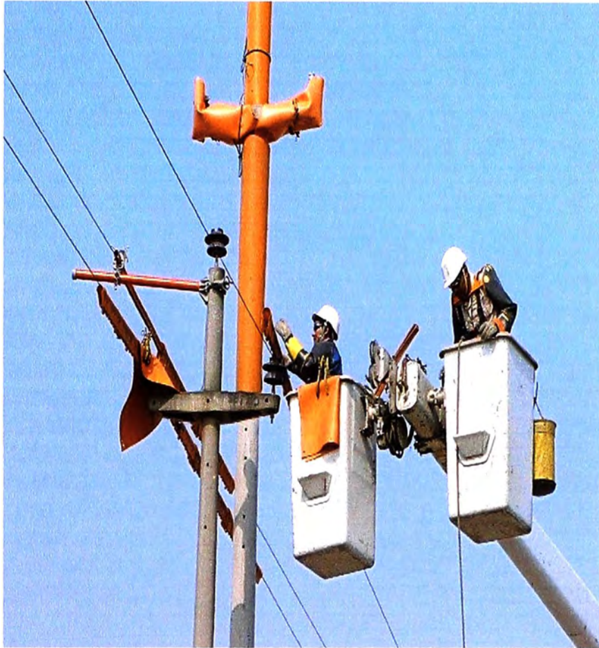
Fig. 3.4 Mantenimiento en caliente
