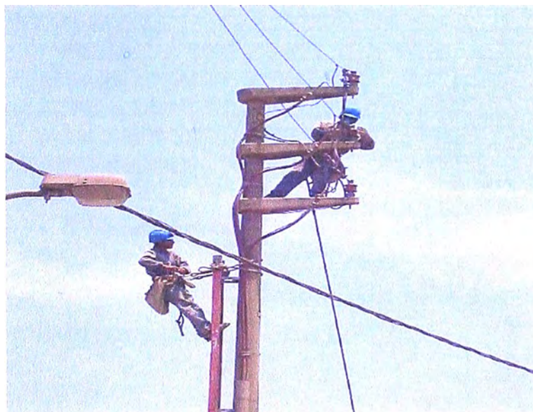
Fig. 3.2 Limpieza y/o cambio de ferreterías
