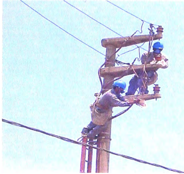
Fig. 3.3 Cambio de conectores
