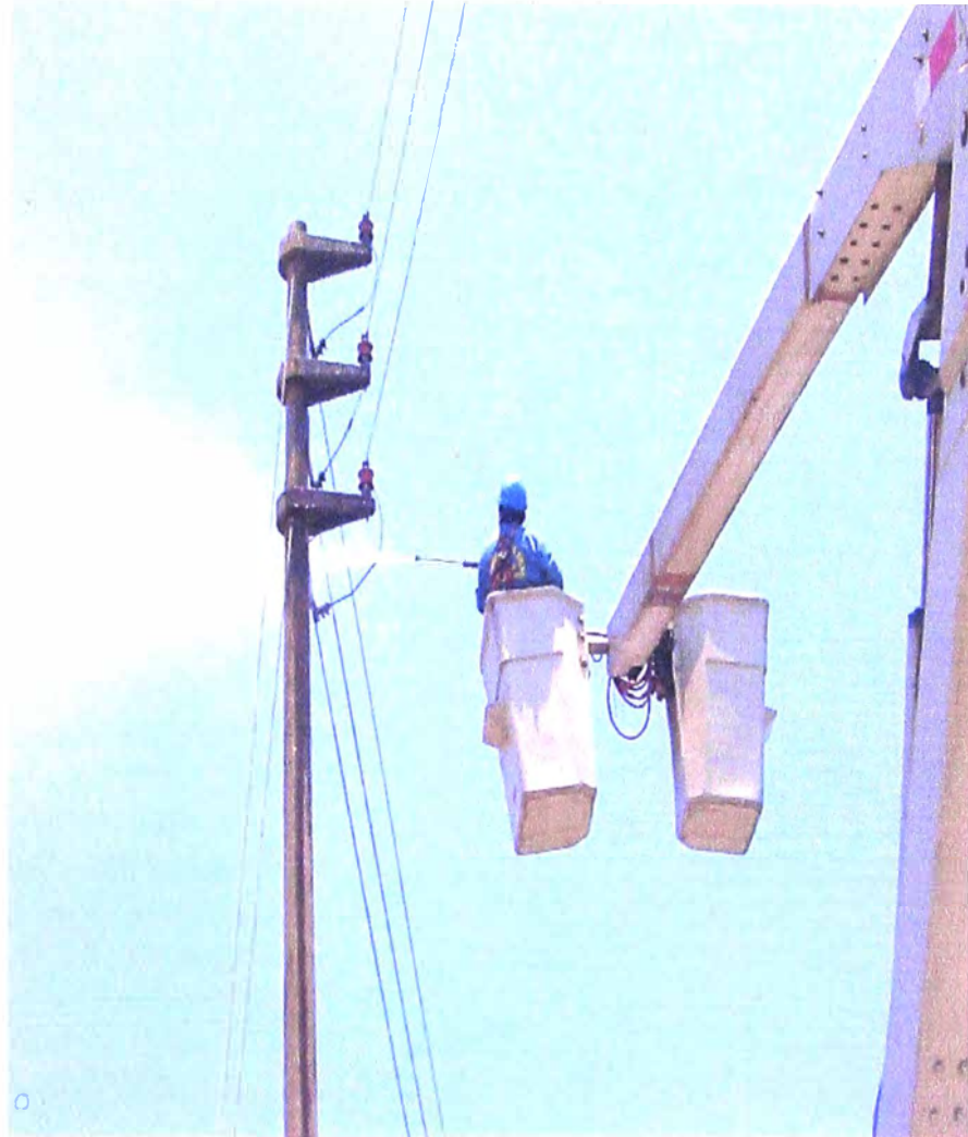
Fig. 3.5 Proceso de hidrolavado
